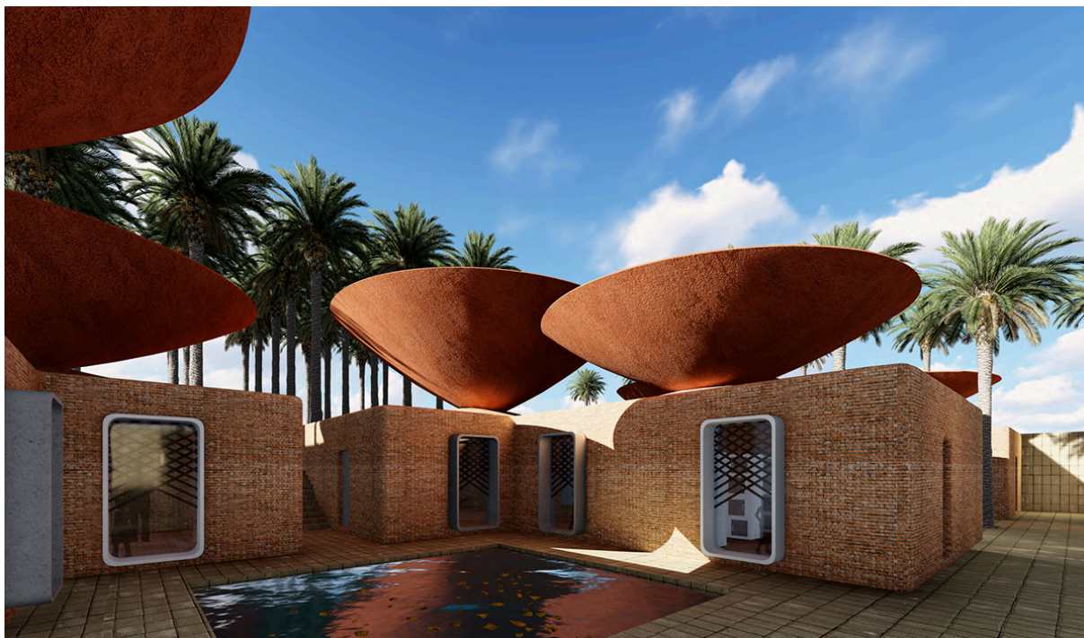
Figura 13: Concave Roof, Irã. Cobertura côncava como dispositivo climático e de captação de água.
