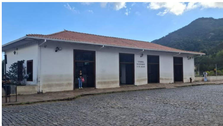
Figura 4 - Fachada do Terminal Rodoviário de Ouro Preto
