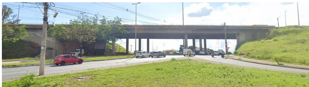
Figura 10 – Vista frontal do viaduto São Francisco
