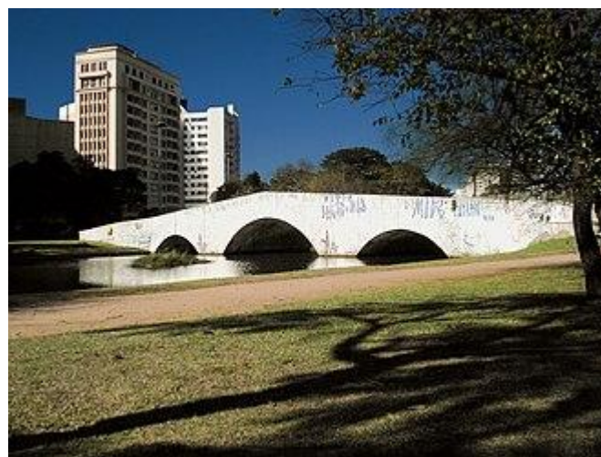
Figura 7 – Aspecto da Ponte de Pedra em 2008 Fonte – Wikipédia, 2025
