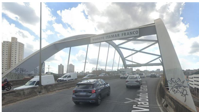
Figura 15 – Vista do viaduto Itamar Franco
