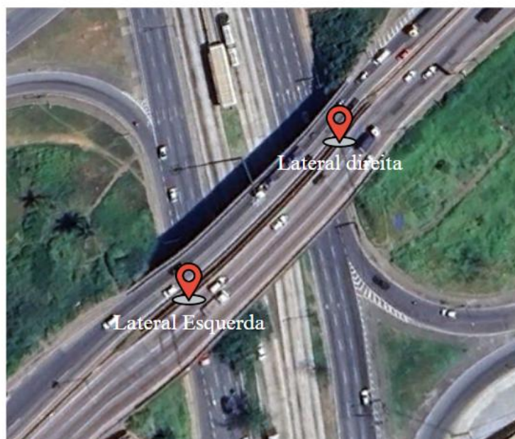
Figura 11 – Vista superior do viaduto São Francisco
