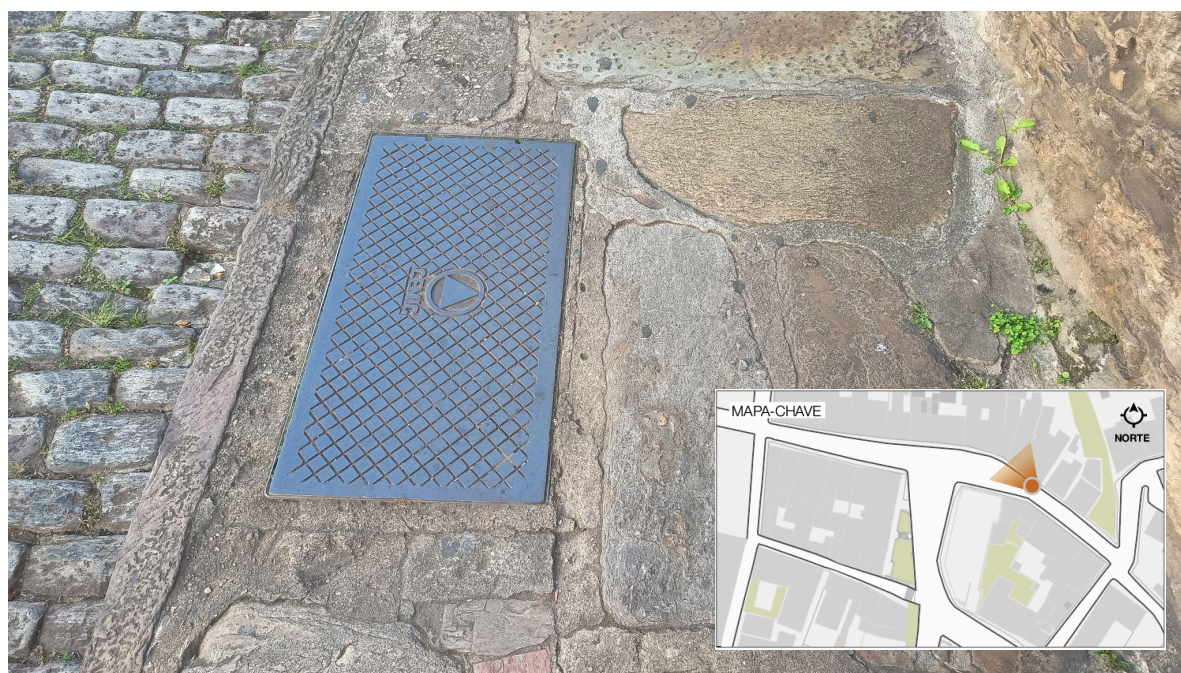
Figura A3 - Placa de manutenção elétrica.
