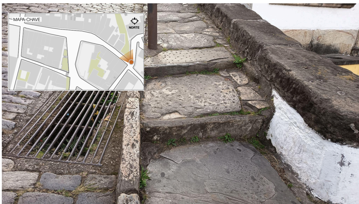
Figura A2 - Adaptação de acessibilidade no passeio da Rua Cláudio Manoel.
