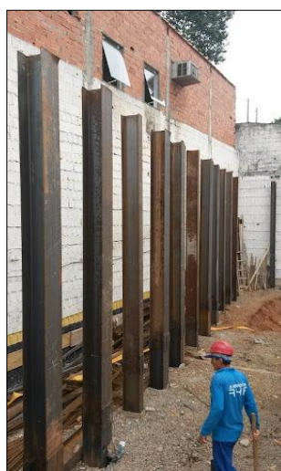
Figura 10: Cravação de perfil metálico
