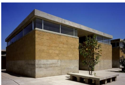
Figura 13 - Elementos lineares em concreto
