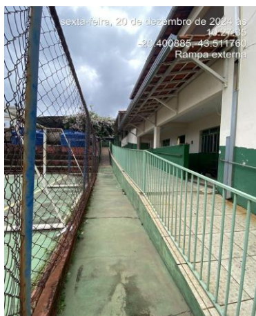
Figura 31 - Rampa de acesso ao pátio
