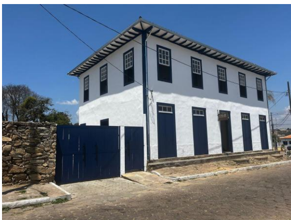
Figura 1- Fachada da Casa de Cultura
