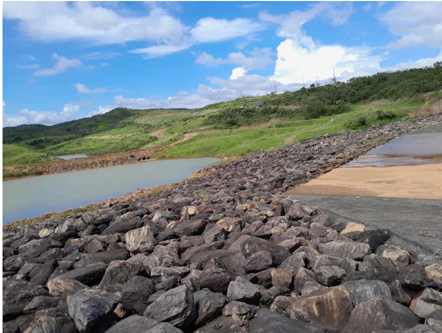
Figura 5: Aplicação de blocos de gnaiss em um dique de armazenamento de água.
