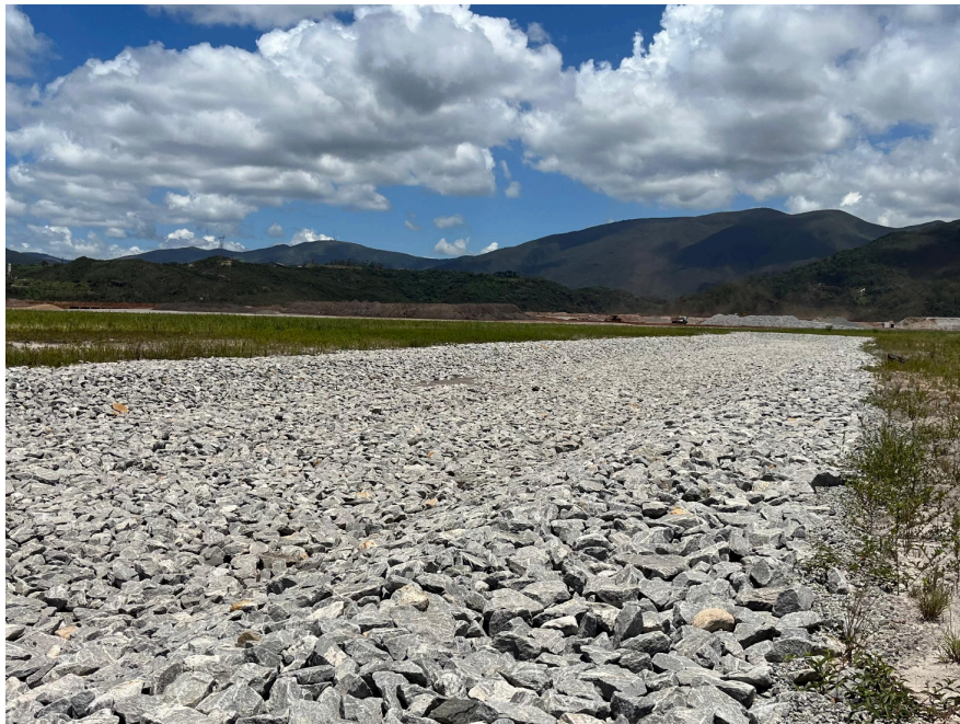
Figura 6: Aplicação de agregados em um sistema de drenagem de pilha de rejeito.
