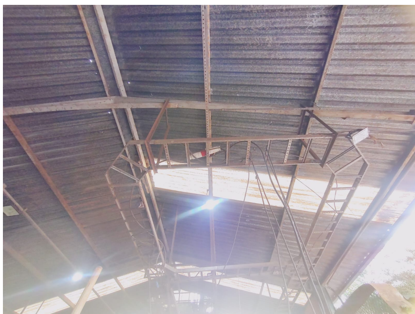
Figura 6 – Cabeamento do inversor para o motor. Fonte: Autor
