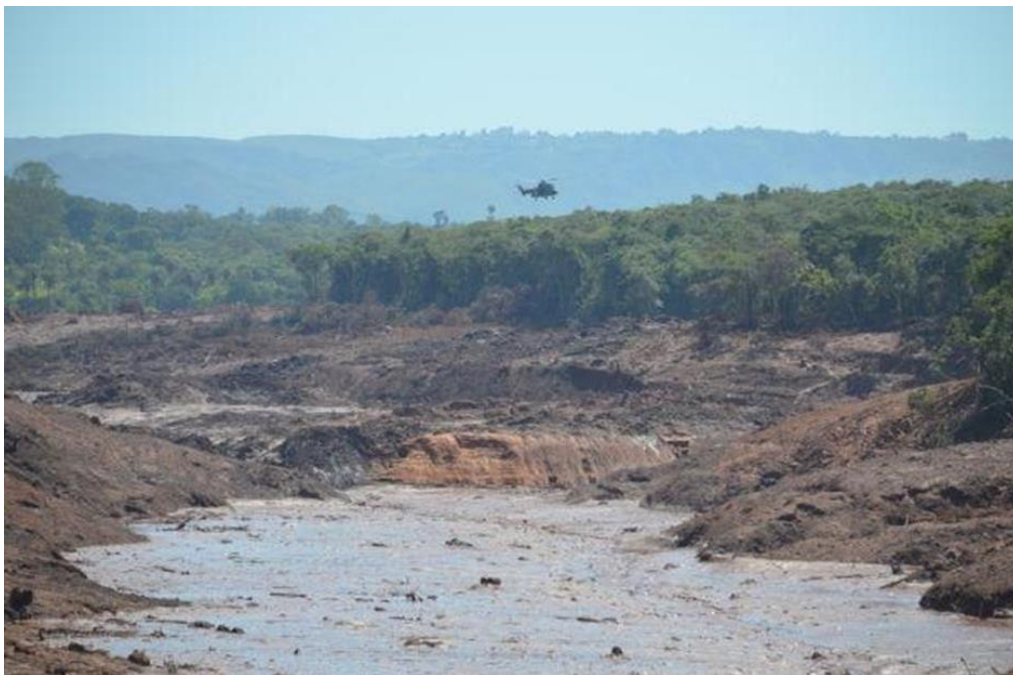
Figura 1 – Barragem de rejeitos rompida em Mariana (MG)
