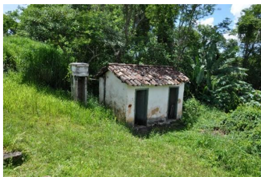
Figura 12. Banheiros. Fonte: a autora, 2020.
