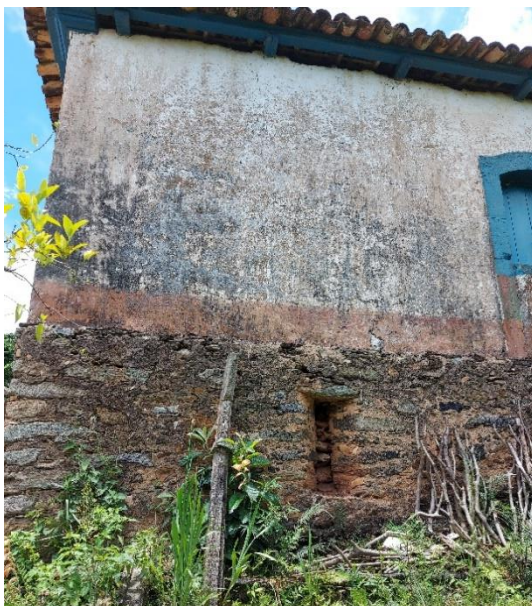
Figura 19. Vãos na estrutura. Fonte: a autora, 2020.
