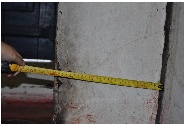
Figura 24. Parede interna e chaminé do fogão. Fonte: a autora, 2020.
