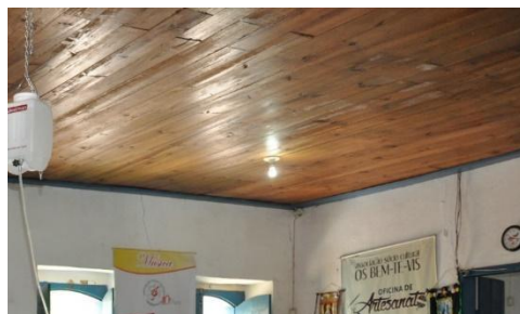
Figura 09. Forro. Fonte: a autora, 2020.
