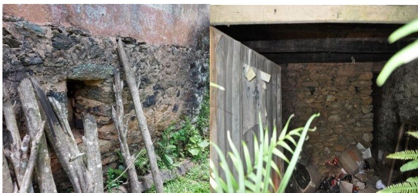
Figura 4 e 5. Estrutura e Porão, respectivamente. Fonte: a autora, 2020.
