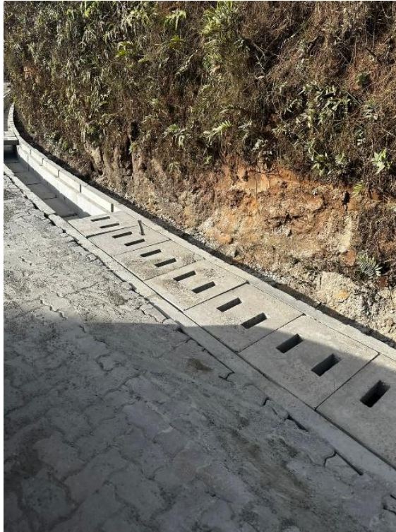
Figura 20 - Pavimentação em blocos de concreto intertravado na Estrada da Purificação
