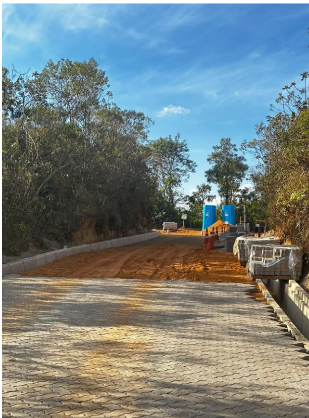
Figura 26 - Trecho da Estrada da Purificação após a pavimentação de seu leito
