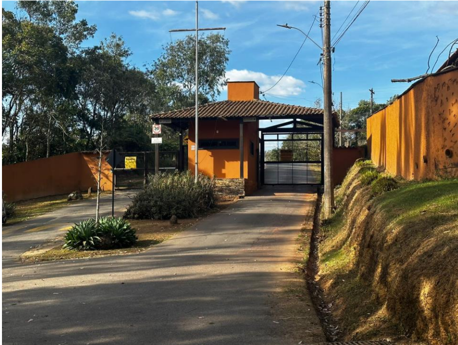
Figura 16 - Portaria do Condomínio Campo Grande de Vila Rica
