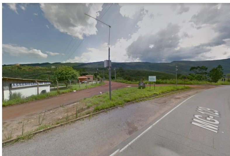
Figura 11 - Entrada da Estrada da Purificação pela MG-129
