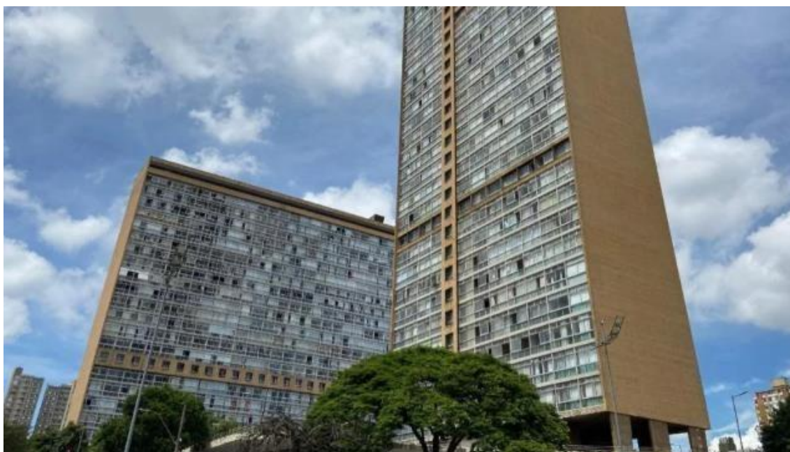
Figura 10: Edifício JK, inaugurado em 1968. O projeto conta com dois blocos e possui no total 1086 apartamentos. Projeto de Oscar Niemeyer
