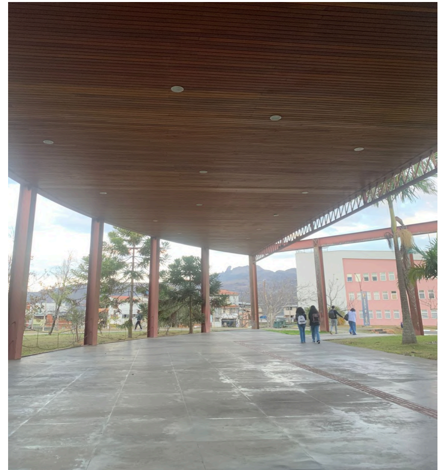
Figura 8 - fotografia da cobertura de entrada da Escola de Minas
