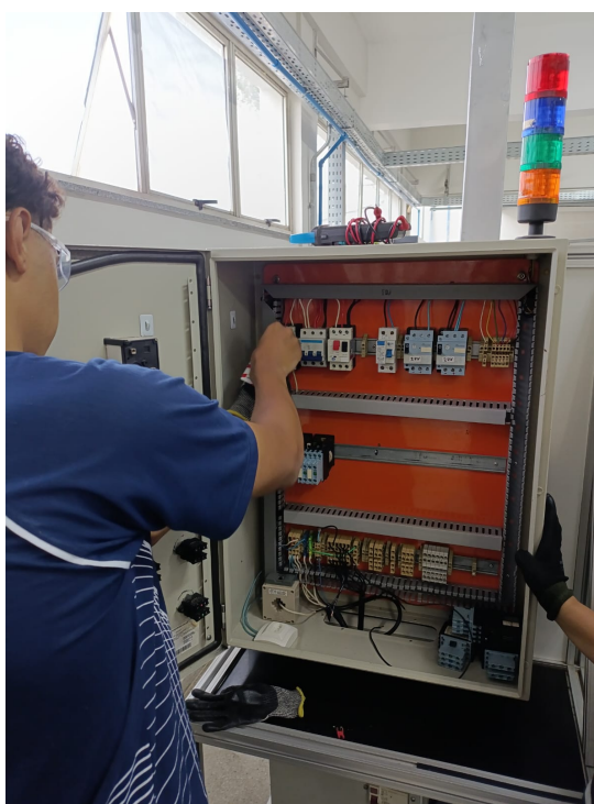
Figura 25 – Aluno realizando o procedimento de bloqueio
