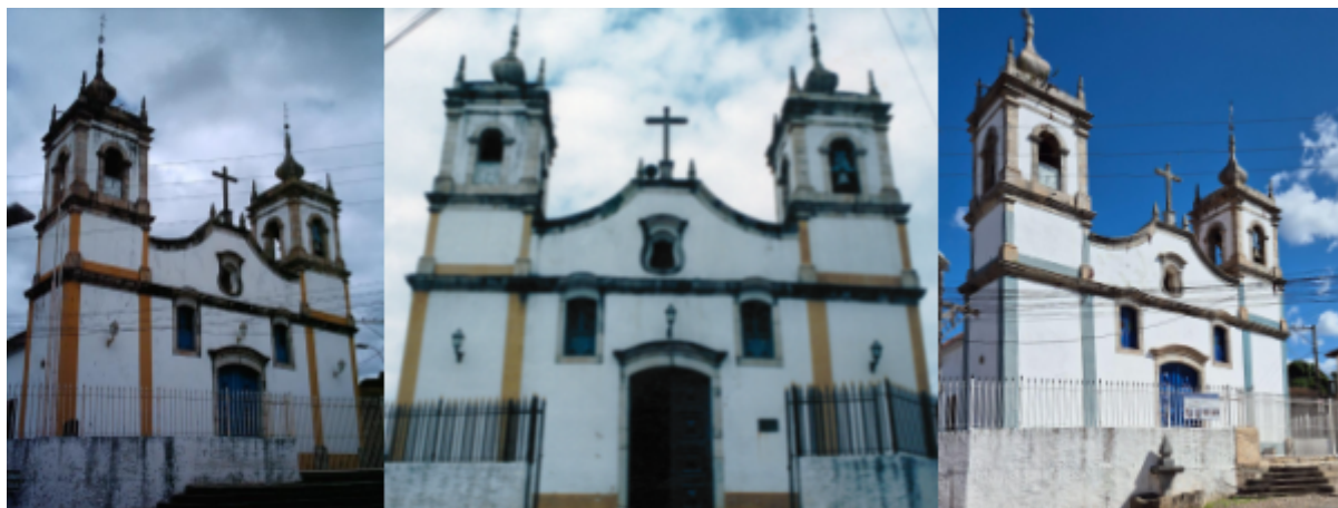
Figura 91: Em sequência, fachada principal da Igreja Matriz de Nossa Senhora da Boa Viagem (Itabirito/MG), antes da execução das reformas iniciadas em 2003, durante a reforma em 2005 e seu atual estado.
