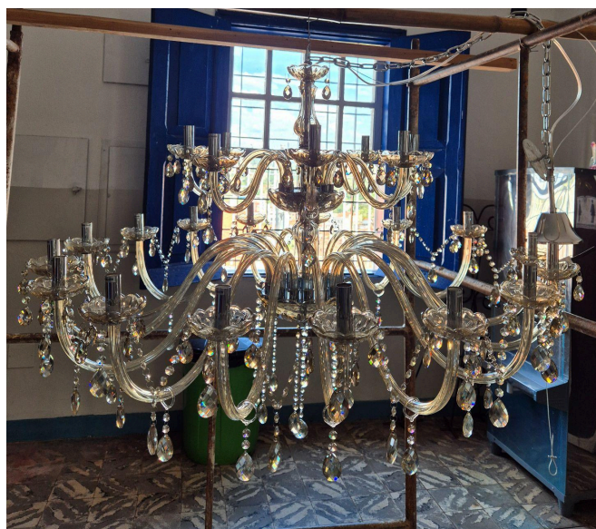
Figura 100: Novos Lustres de Cristal Âmbar da Matriz de Nossa Senhora da Boa Viagem antes da instalação. (Itabirito/MG). Fonte: Arquivo Pessoal. 05 de Novembro de 2025.
