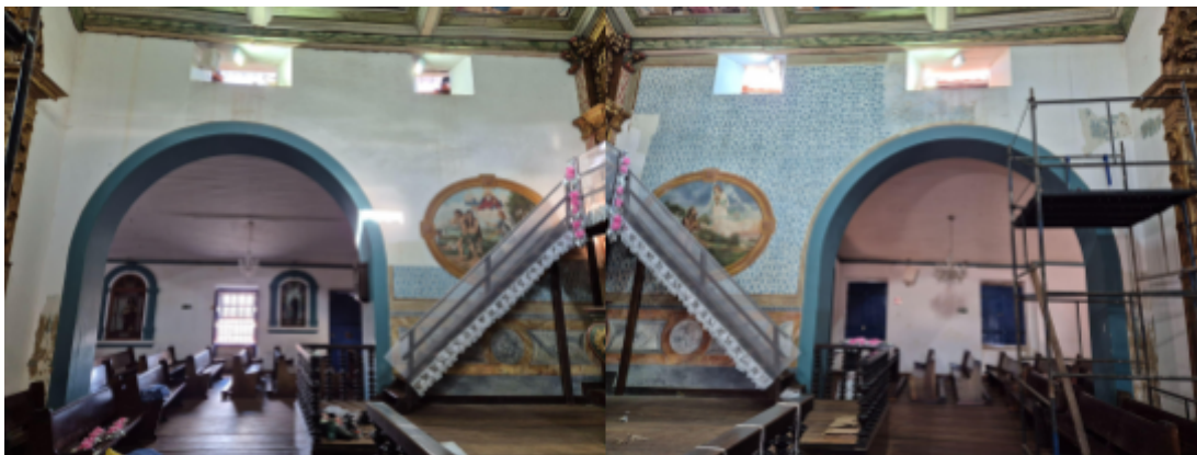
Figura 55: Arcos do presbitério da Igreja de Nossa Senhora da Boa Viagem (Itabirito/MG);
