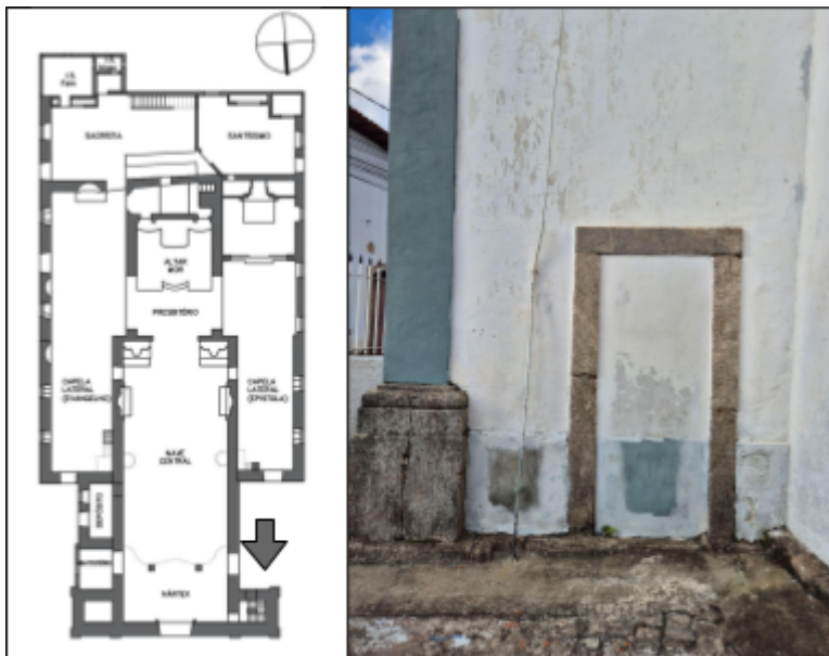
Figura 161: Porta tamponada na torre direita da Matriz de Nossa Senhora da Boa Viagem - lado externo;
