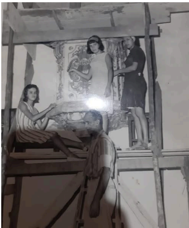
Figura 63: Restauo do Púlpito do lado do evangelho da Igreja da Boa Viagem na década de 1960; Fonte:RODRIGUES, Pelota; Reforma da Igreja da Boa Viagem na década de 60; Facebook, 31 jul. 2022.
