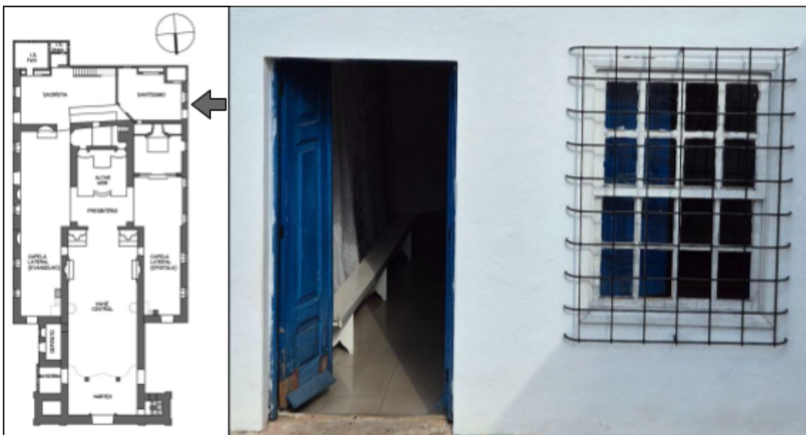
Figura 154: Janela e porta da capela do santíssimo da Matriz de Nossa Senhora da Boa Viagem na fachada lateral direita;
