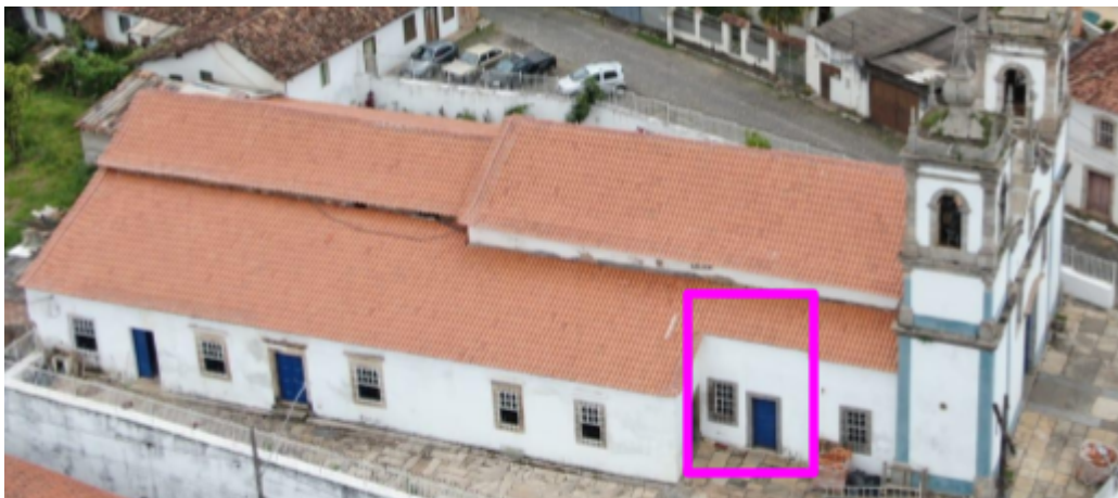
Figura 56: Lateral Esquerda (evangelho) da Igreja de Nossa Senhora da Boa Viagem (Itabirito/MG); Destaque para o anexo provavelmente construído durante o paróquiato do Padre Padre Antônio Firmino Mota (1936-1941)
