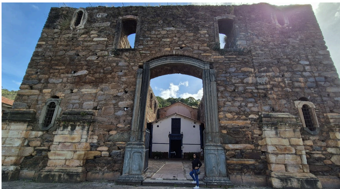
Figura 13:Igreja de Nossa Senhora do Rosário, em Sabará (MG).
