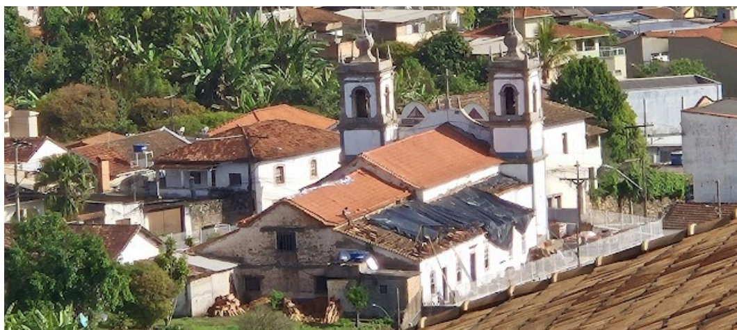
Figura 93: Vista Posterior da Igreja Matriz de Nossa Senhora da Boa Viagem (Itabirito/MG) durante a reforma de seu telhado;
