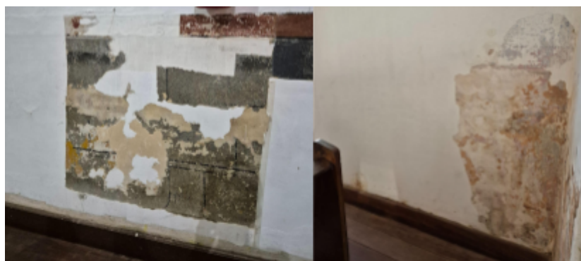
Figura 98: Janelas de Prospecção abertas, respectivamente, na Nave e capela lateral direita (capela do santíssimo) da Matriz de Nossa Senhora da Boa Viagem (Itabirito/MG).
