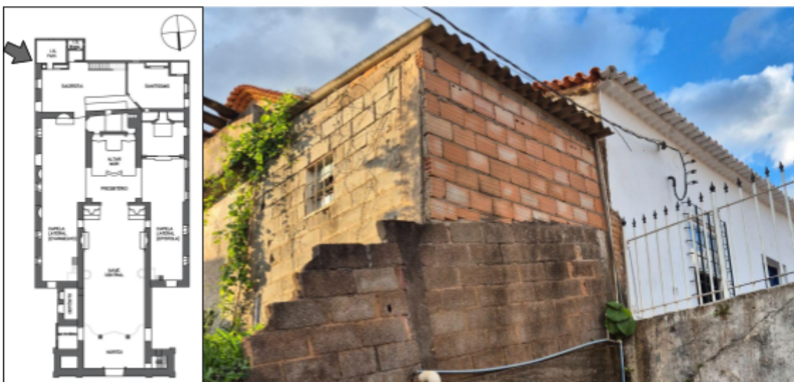
Figura 140: Anexos (apêndices) da Matriz de Nossa Senhora da Boa Viagem - fachada lateral esquerda; Fonte: Arquivo Pessoal; 12 de Novembro de 2025.
