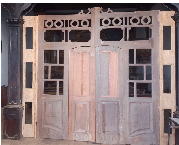
Figura 97: Processo de reintegração da porta tapa-vento Igreja Matriz de Nossa Senhora da Boa Viagem (Itabirito/MG);
