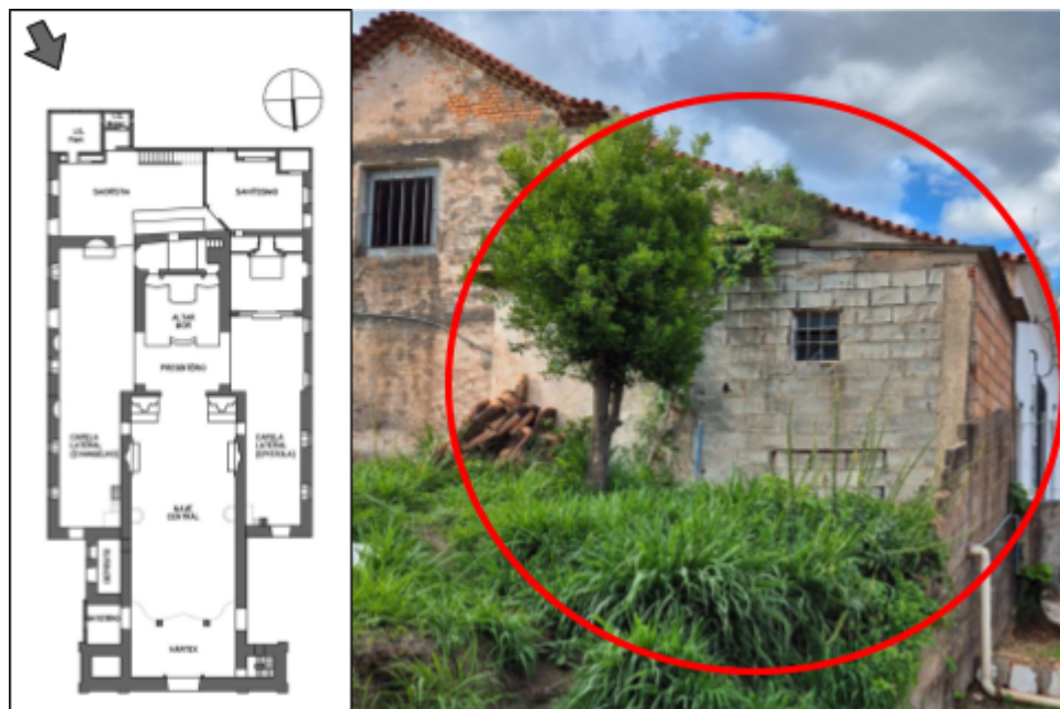
Figura 121: Apêndices que comportam os sanitários da Igreja de Nossa Senhora da Boa Viagem; Fonte: Arquivo Pessoal. 12 de Novembro de 2025.
