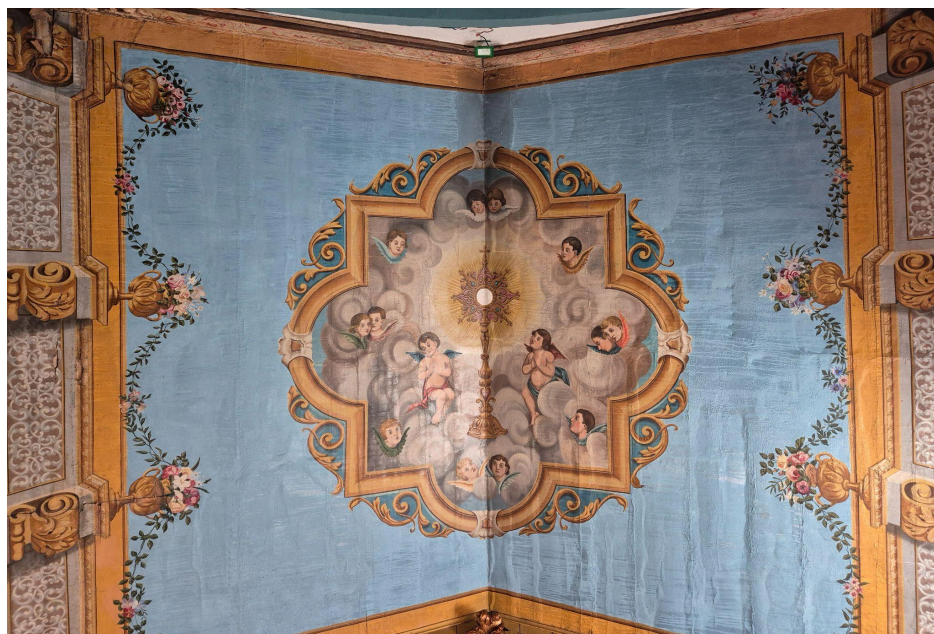
Figura 189: Forro da Capela do Senhor dos Passos (antiga capela do santíssimo) da Matriz de Nossa Senhora da Boa Viagem;
