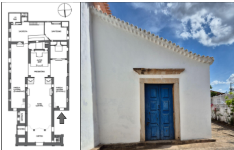
Figura 158: Porta de entrada para a capela lateral direita da Matriz de Nossa Senhora da Boa Viagem; Fonte: Arquivo Pessoal; 12 de Novembro de 2025.
