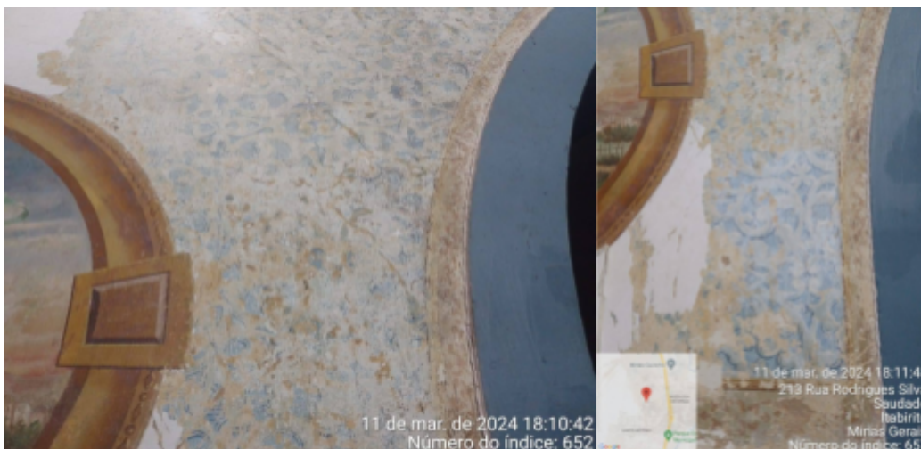
Figura 92: Pinturas encontradas na Capela Mor da Igreja Matriz de Nossa Senhora da Boa Viagem (Itabirito/MG) durante processo de inspeção do imóvel;
