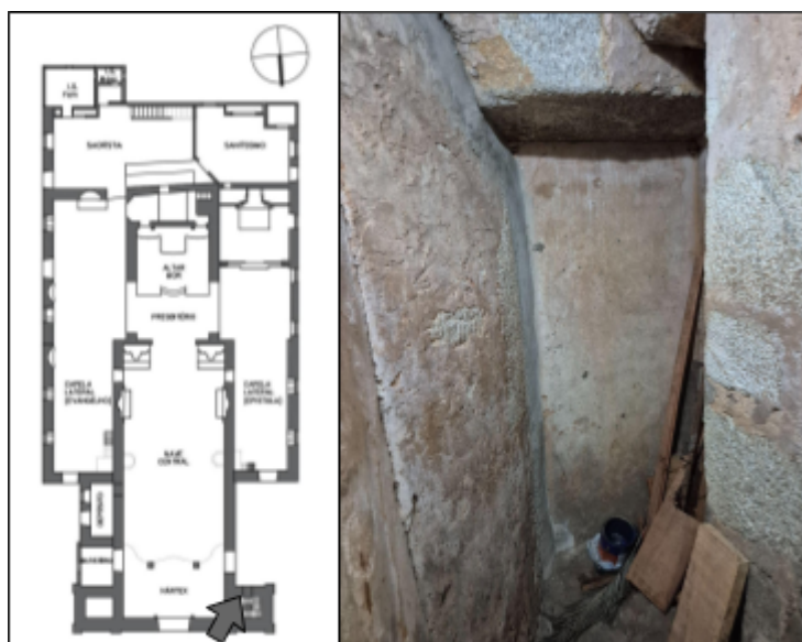
Figura 162: Porta tamponada na torre direita da Matriz de Nossa Senhora da Boa Viagem - lado interno;
