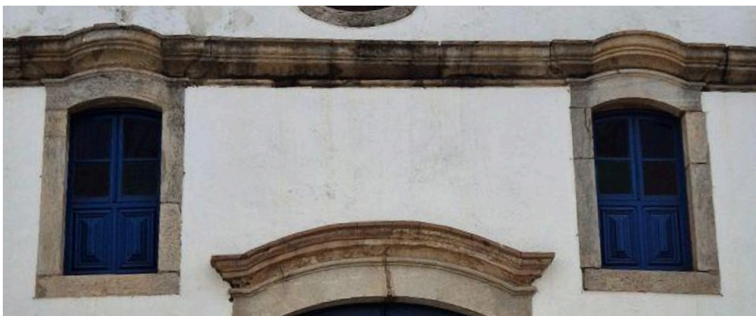
Figura 131: Janelas da Fachada Frontal da Matriz de Nossa Senhora da Boa Viagem; Fonte: Arquivo Pessoal; 05 de Novembro de 2025.
