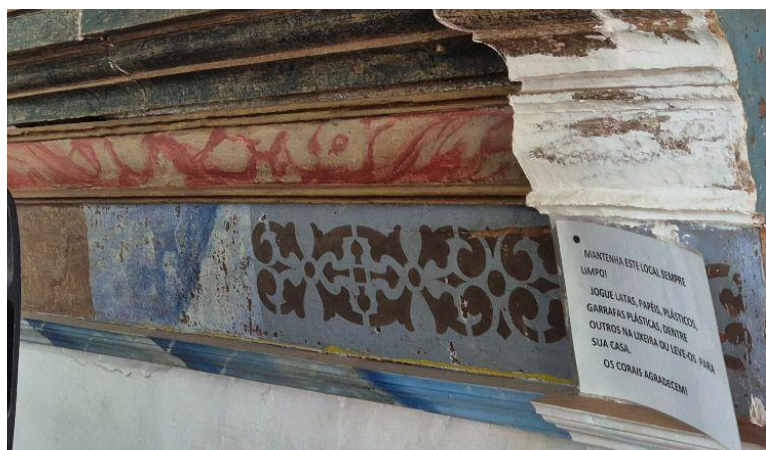
Figura 66: Pinturas de Barrado das cimalthas do Forro da Nave da Igreja de Nossa Senhora da Boa Viagem (Itabirito/MG), da esquerda para direita, o barrado mais antigo encontrado (marrom), seguindo-se de duas pinturas de diferentes períodos; Fonte: Arquivo Pessoal. 02 de Maio de 2025.
