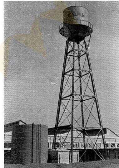
1953: Cia. Brasileira de Armazéns Gerais — Caixa d'água tipo "Hintze", de 200 m 3 de capacidade, sobre torre de 30 m de altura. (Diversas caixas d'água semelhantes foram montadas no Brasil).
