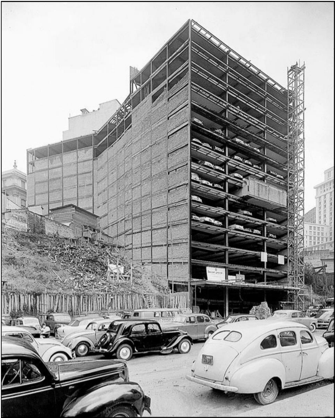
Figura 26 – Edifício Garagem América.
