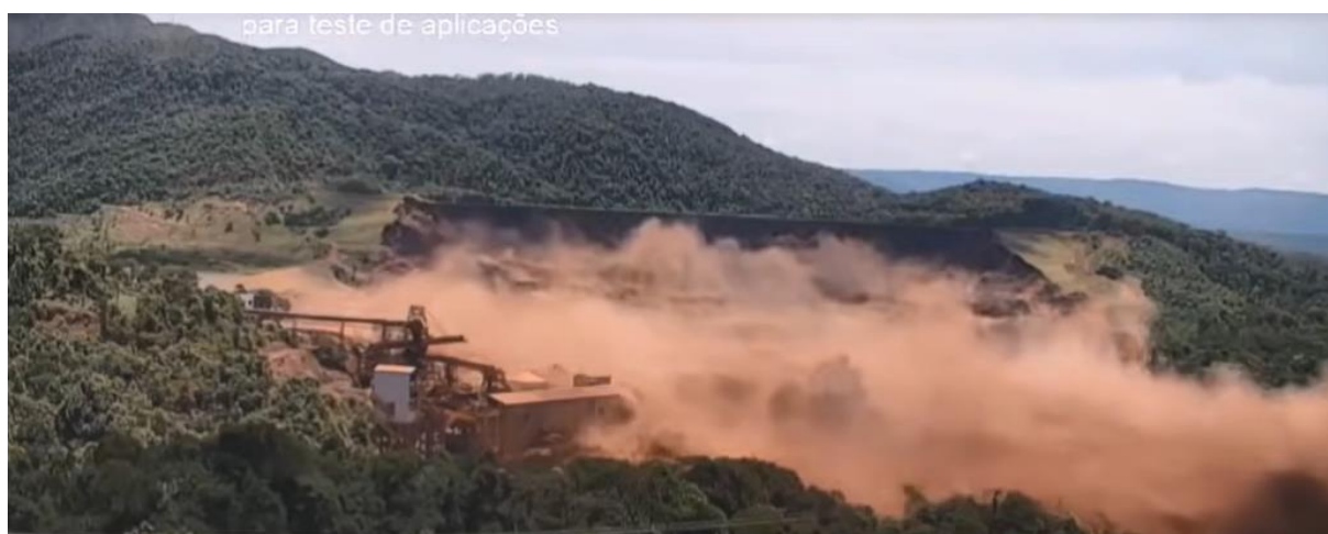
Figura 2: Colapso estrutural da Barragem de Fundão
