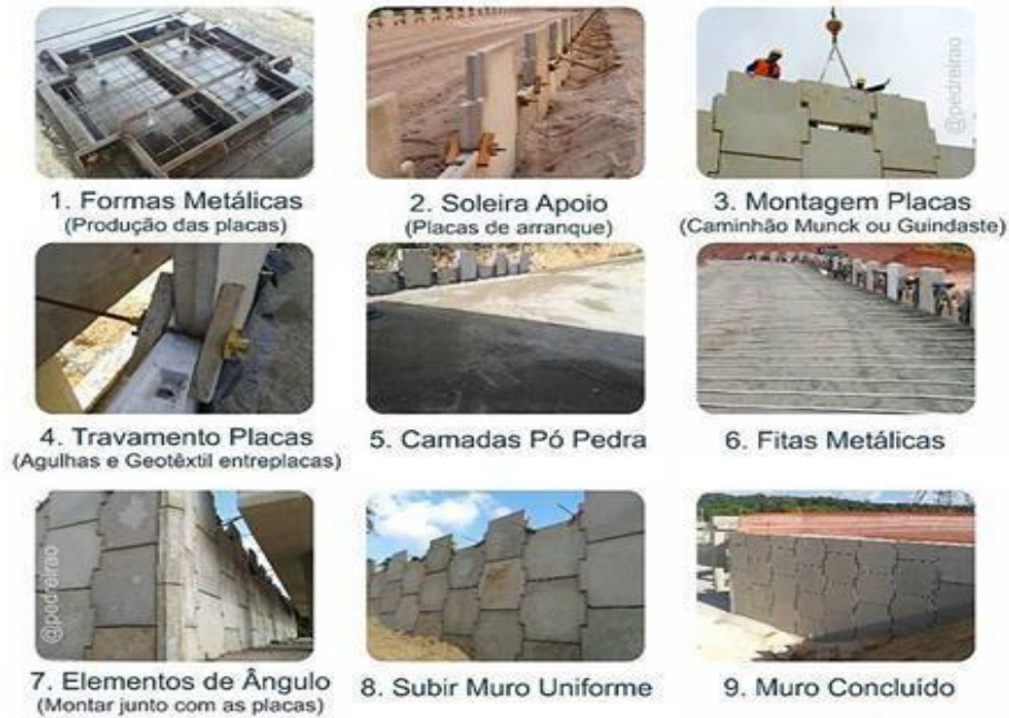
Figura 6 - Processo construtivo do sistema Terra Armada
