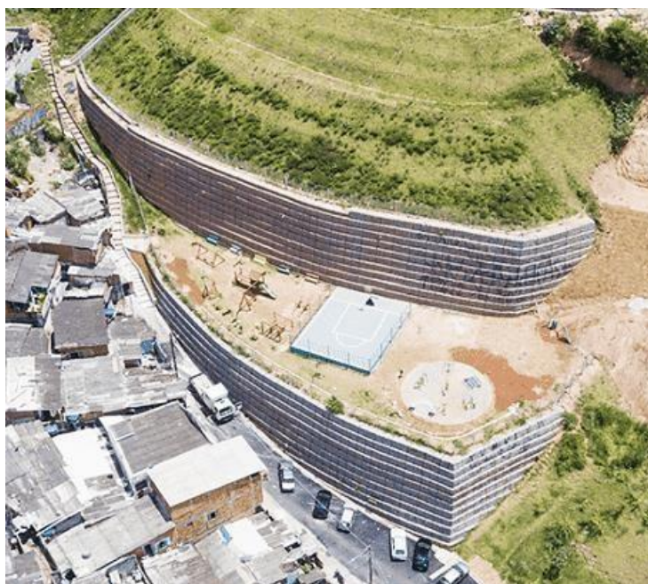
Figura 13 - Obra realizada em Terramesh no Jardim São Camilo, em Jundiaí - SP.
