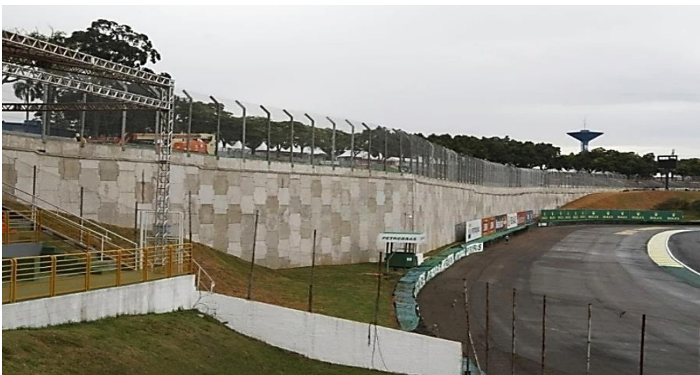
Figura 7 - Obra realizada em Terra Armada no Autódromo José Carlos Pace, em São Paulo - SP.
