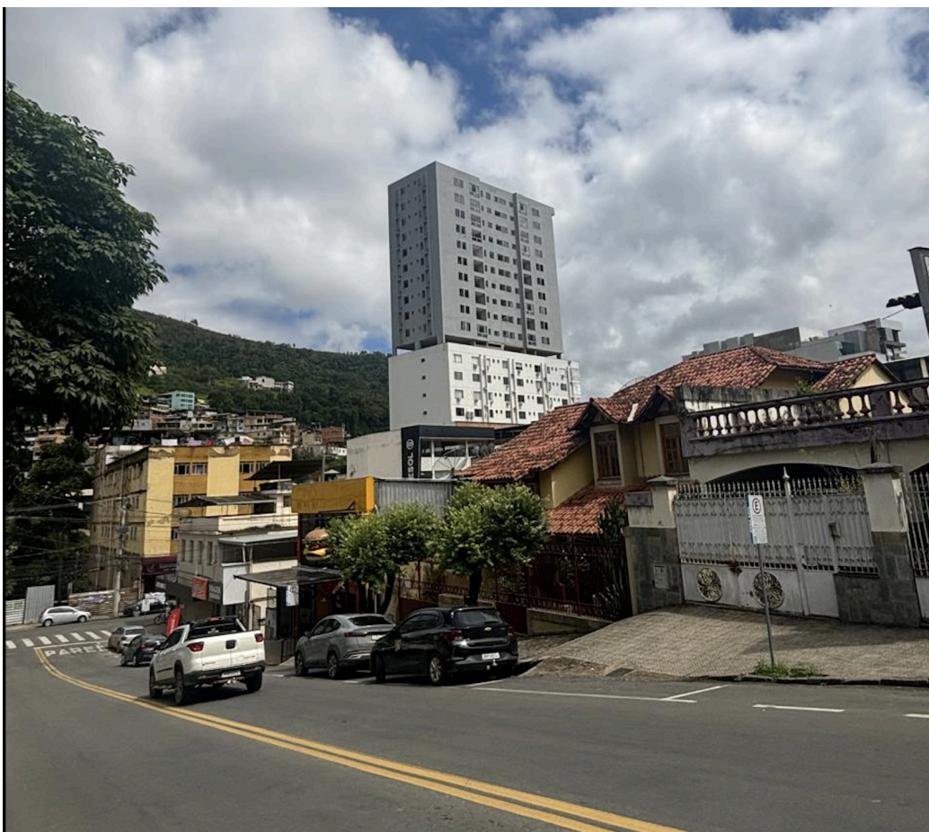
Figura 12: Edifício em fase final de construção no centro de Manhuaçu, onde a falta de controle rígido a partir da legislação fica evidente. 2025. Fonte: Acervo pessoal.
