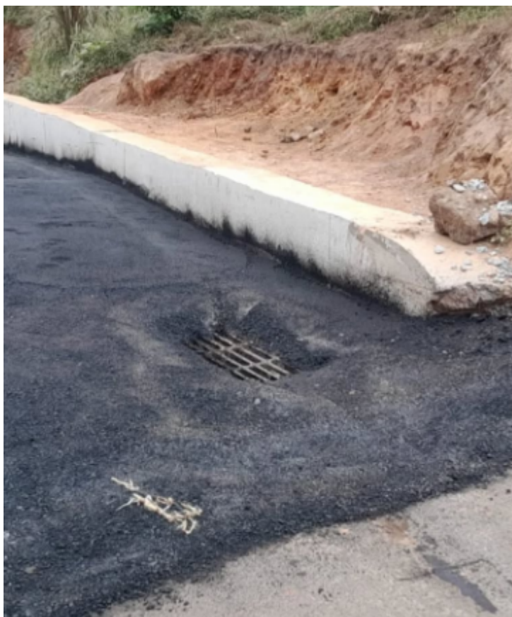
Imagem 4 - Obras realizadas de drenagem realizada no Taquaral
