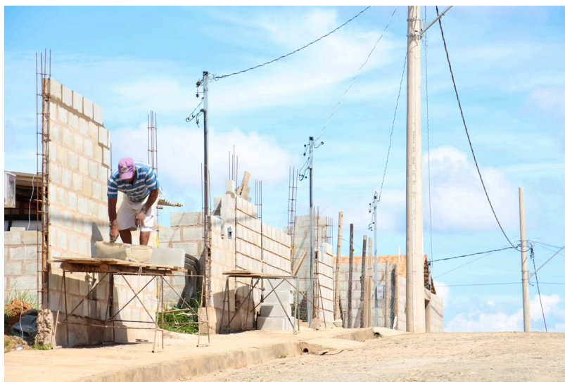
Imagem 1 - Exemplo de autoconstrução na cidade de Ouro Preto
