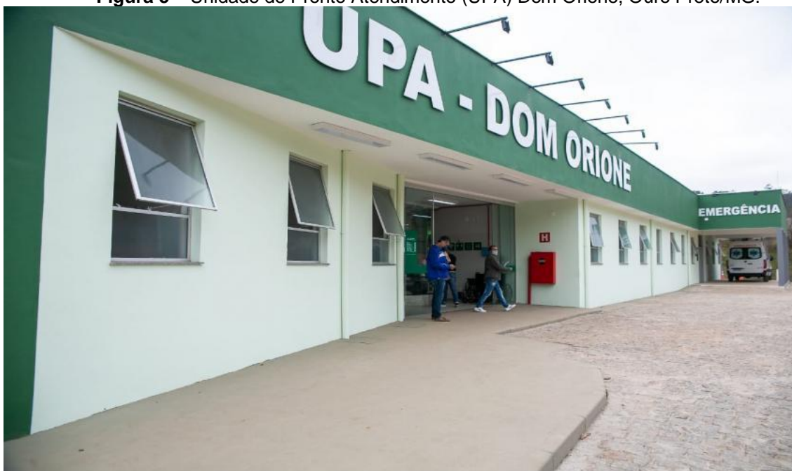
Figura 5 – Unidade de Pronto Atendimento (UPA) Dom Orione, Ouro Preto/MG.
