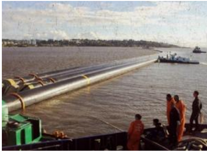
Figura 6 - Emissário em construção – Rio Guaíba/RS
