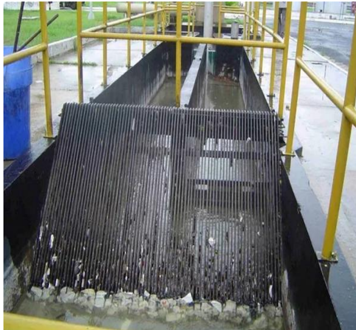
Figura 10 - Gradeamento da etapa preliminar
