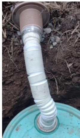
Figura 11: Buraco escavado para a adição de brita, tubo PVC e o reservatório
