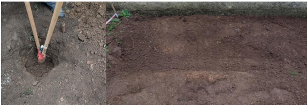
Figura 8: Escavação do compartimento central e da cavidade da instalação do reservatório
