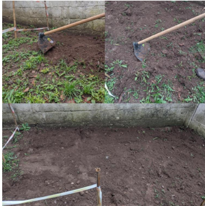
Figura 8: Escavação do compartimento central e da cavidade da instalação do reservatório
