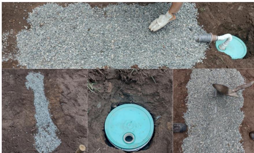
Figura 11: Buraco escavado para a adição de brita, tubo PVC e o reservatório
