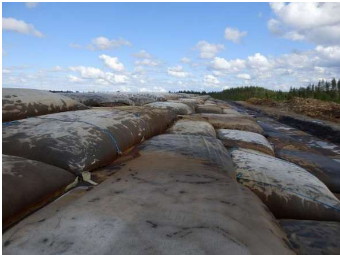
Figura 8 – Empilhamento drenado por meio de tubos geotêxteis
