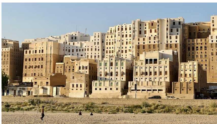
Figura 67. Edificações feitas em adobe na cidade de Shibam, no Iêmen (séculos XVI e XVII)
