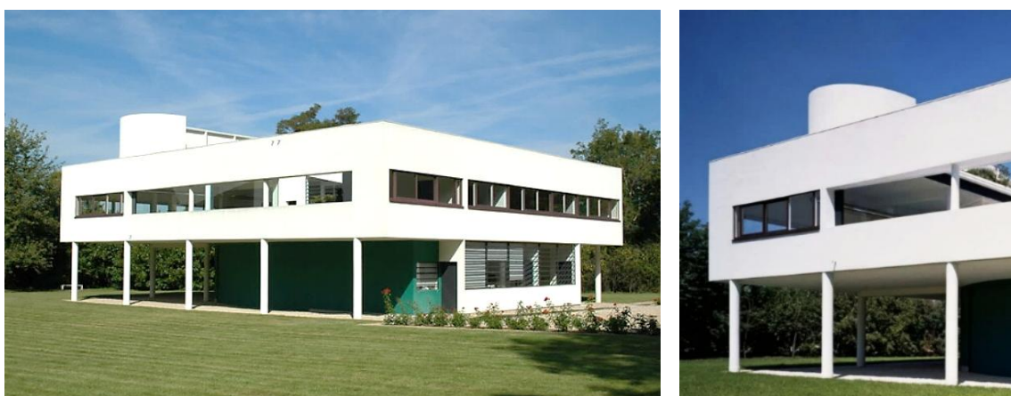
Figuras 7 e 8. Villa Savoye e os "cinco pontos da nova arquitetura", Le Corbusier (1928)
