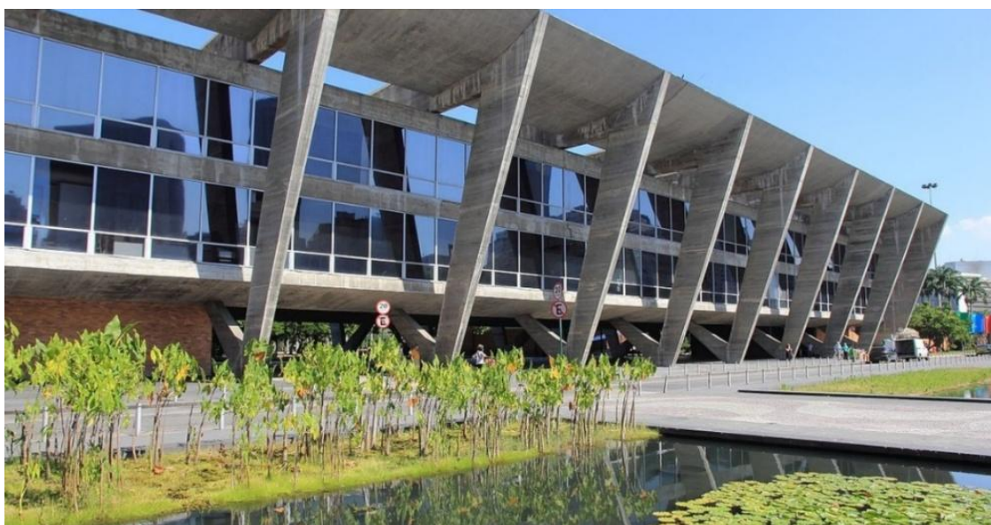
Figura 66. Museu de Arte Moderna do Rio de Janeiro, Affonso Reidy (1954)
