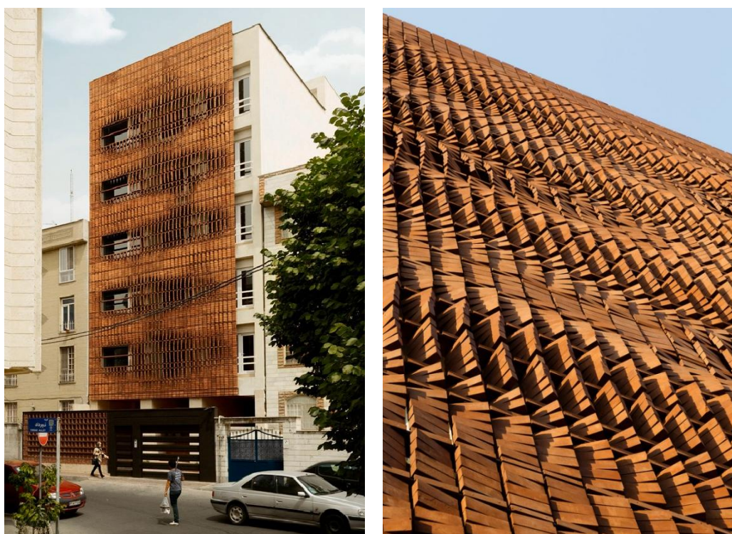
Figuras 77, 78, 79 e 80. Fachada e detalhes construtivos do Edifício Cloaked in Bricks (2015)
