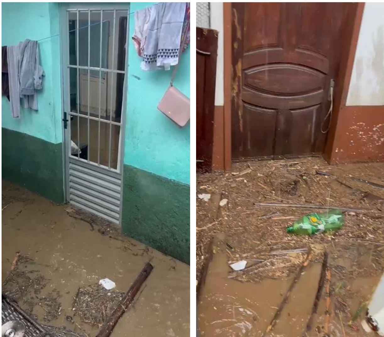
Figura 20 – Água adentrando residências durante alagamento no bairro Barro Preto, Mariana – MG, em 24 de janeiro de 2026.
