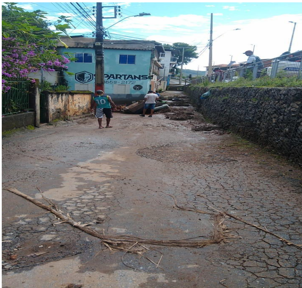
Figura 15 – Resíduos e danos em via pública no bairro Barro Preto, Mariana – MG, após alagamento de 22 de fevereiro de 2021.
