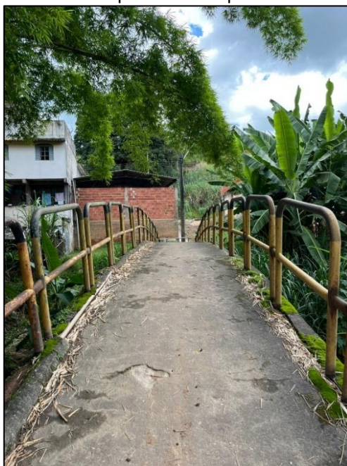
Figura 31 – Travessia presente em ponto crítico do córrego
