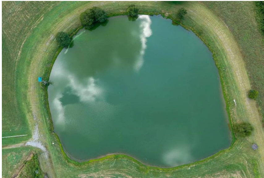
Figura 9 – Bacia de retenção
