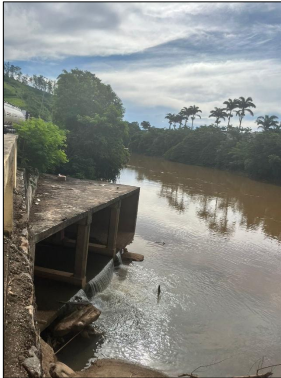
Figura 33 - Estrutura de bueiro na foz do córrego
