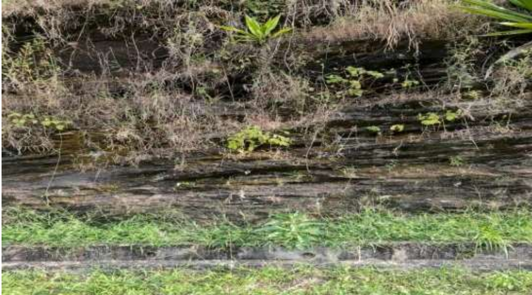
Figura 7 - Bairro Barra: Imagem do maciço rochoso.
