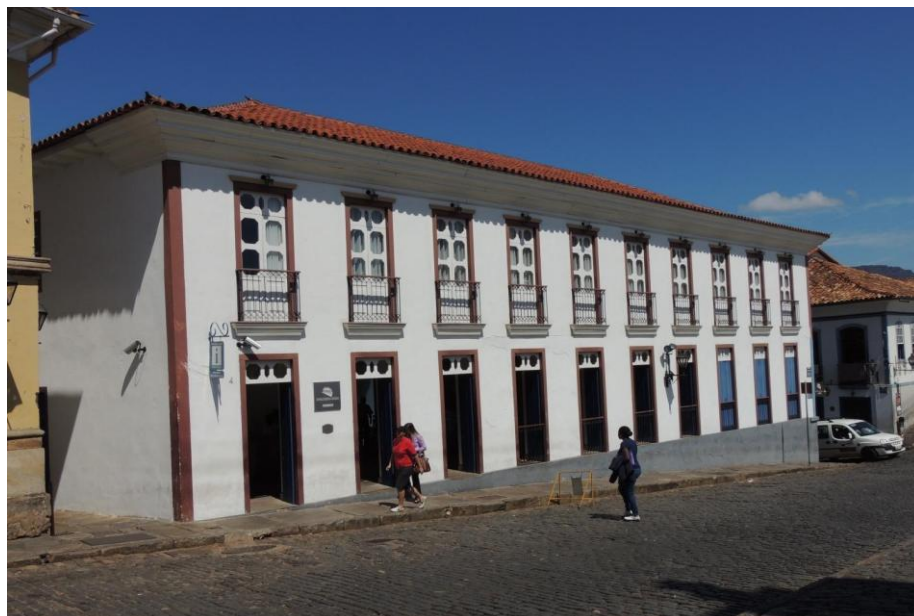
Figura 3 - Fachada atual do antigo Hotel, agora Centro Cultural Sesi-Fiemg, na Praça Tiradentes, Ouro Preto
