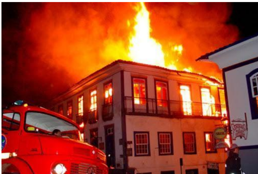
Figura 2 – Incêndio no antigo Hotel Pilão, Praça Tiradentes, Ouro Preto (14/04/2003)
