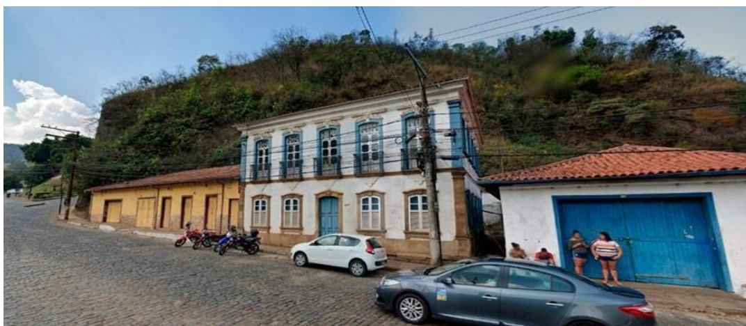
Figura 5 - Fachada antes do deslizamento
