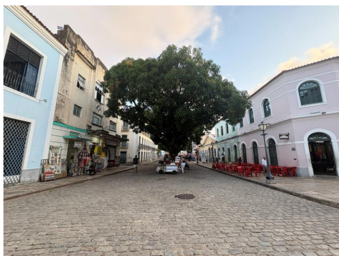
Figura 58 - Vista para a rua da Estrela (Vista 02)
