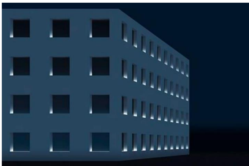
Figura 89 - Iluminação de elementos vazados
