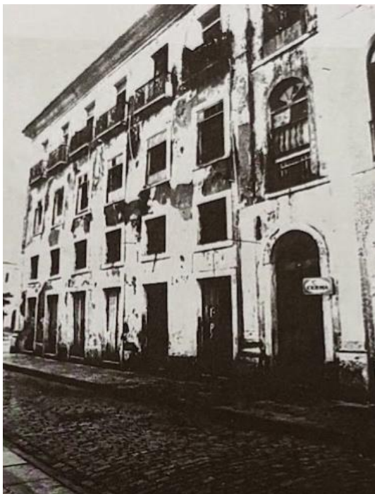
Figura 44 - Sobrado da Rua Portugal em ruínas, datado de 1988
