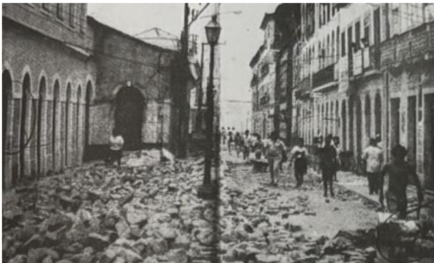
Figura 46 - Reforma na Rua Portugal
