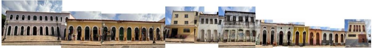
Figura 51 - Montagem da face de quadra B
