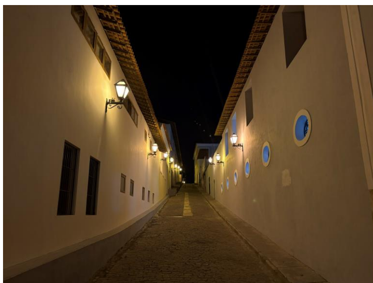
Figura 82 - Complexo Trapiche Santo Ângelo, com utilização de lâmpadas LED, evidenciado pela presença de drivers anexados ao braço da luminária
