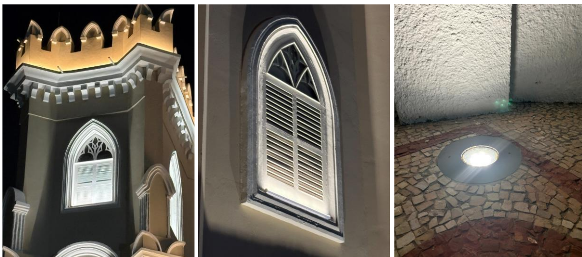
Figura 26 - Detalhes das luminárias utilizadas na iluminação da igreja de Santo Antônio
