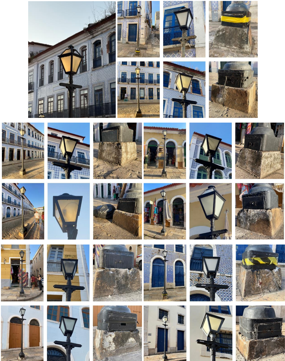
Figura 65 - Levantamento das condições dos postes da rua Portugal
