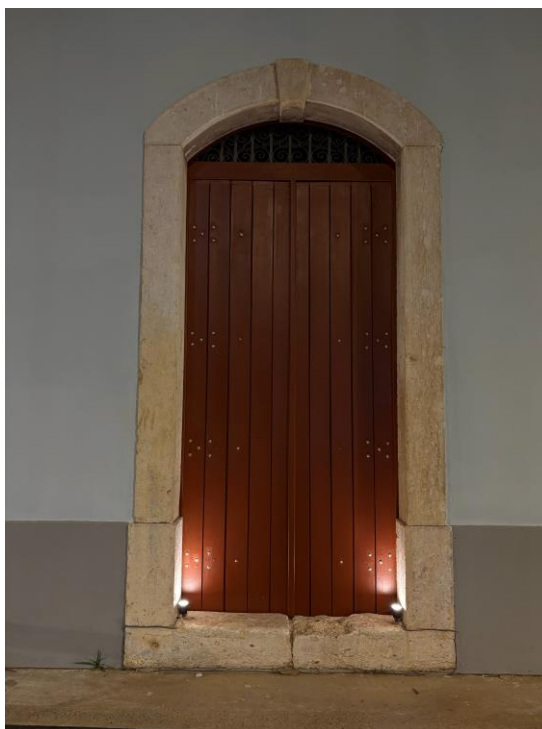
Figura 16 - Passagem de fiação para ligação das luminárias do Armazém Luiz Phelipe Andrés no Complexo Trapiche Santo Ângelo, em São Luís do Maranhão
