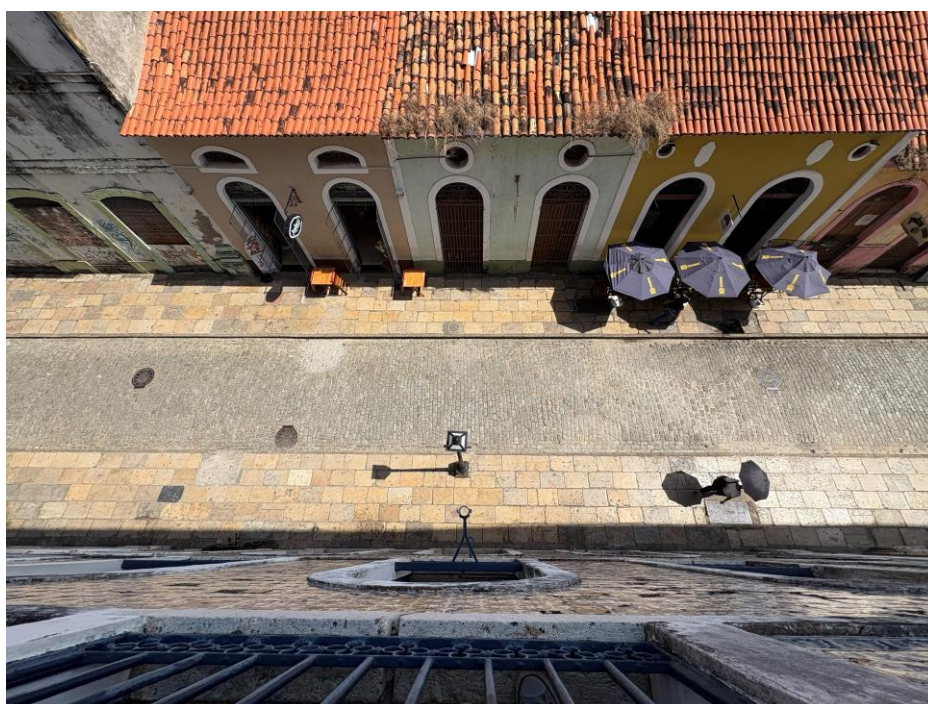
Figura 60 - Vista superior de trecho da rua Portugal
