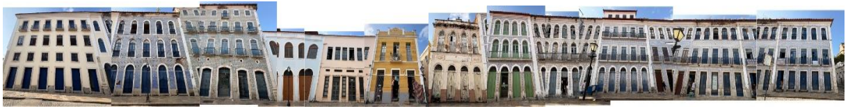
Figura 50 - Montagem da face de quadra A
