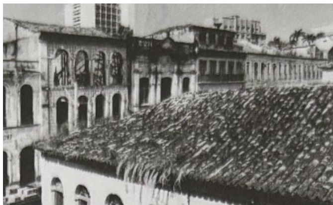
Figura 43 - Casario da Rua Portugal em ruínas
