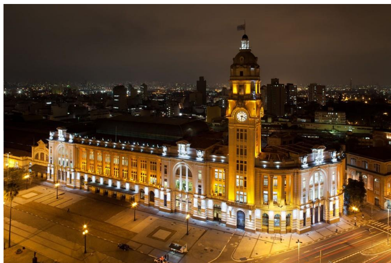
Figura 13 - Estação Júlio Prestes, em São Paulo, iluminada por lâmpadas com diferentes temperaturas de cor
