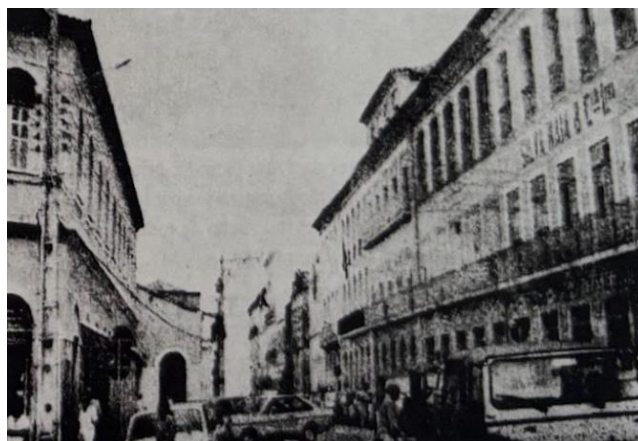
Figura 37 - Cartão fotográfico da Rua Portugal datado de 1979
