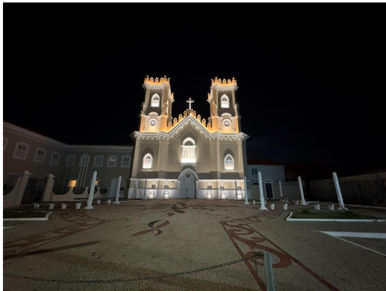
Figura 27 - Vista para a fachada frontal da igreja de Santo Antônio, com o Convento de Santo Antônio à esquerda
