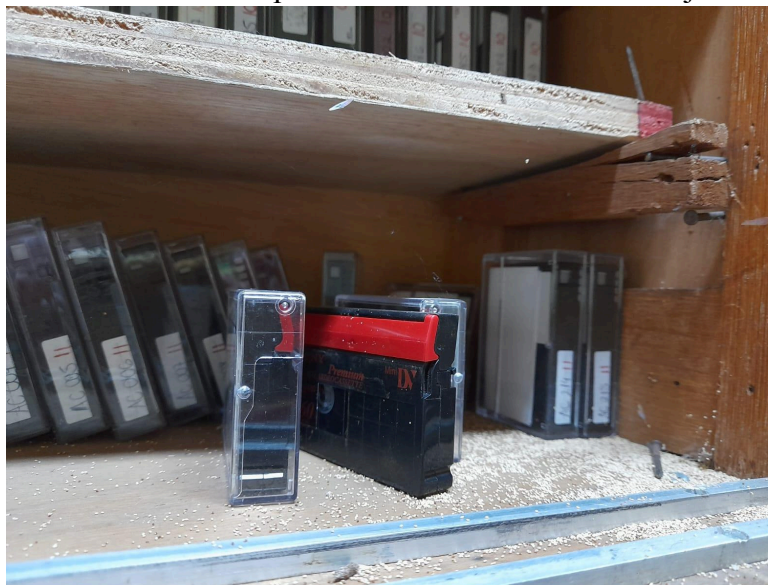
Figura 39- Excrementos de cupim identificados no mobiliário junto às fitas MiniDV.
