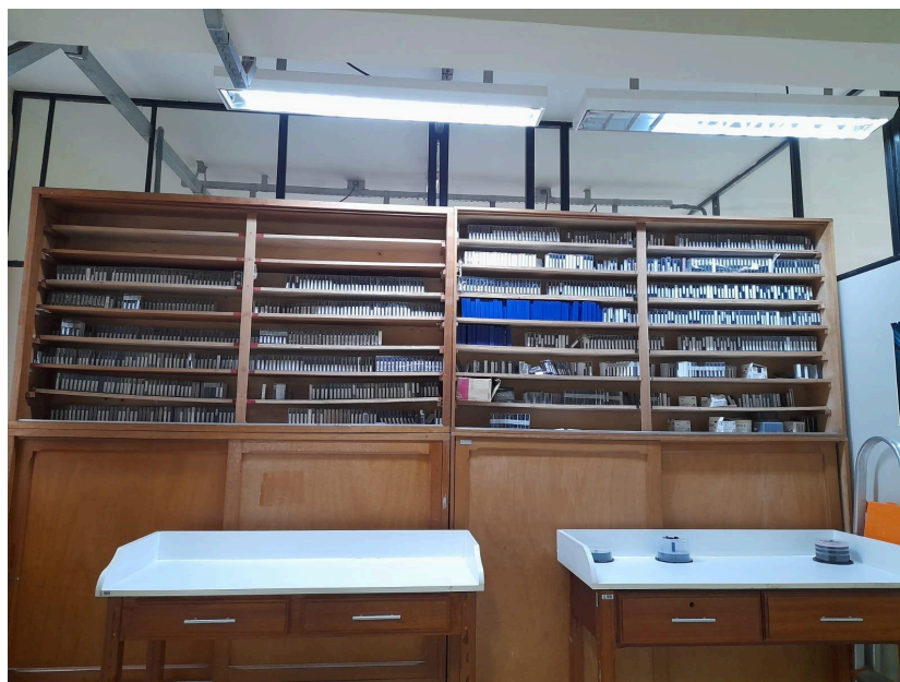
Figura 36- Iluminação direta sobre o acervo durante todo o dia, proveniente de lâmpadas tubulares de LED instaladas no corredor.
