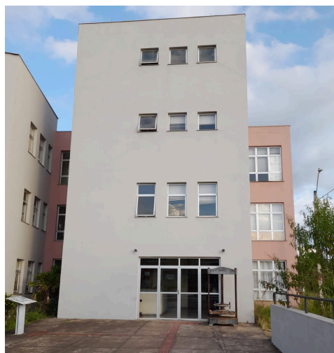
Figura 30- Porta de entrada do prédio
