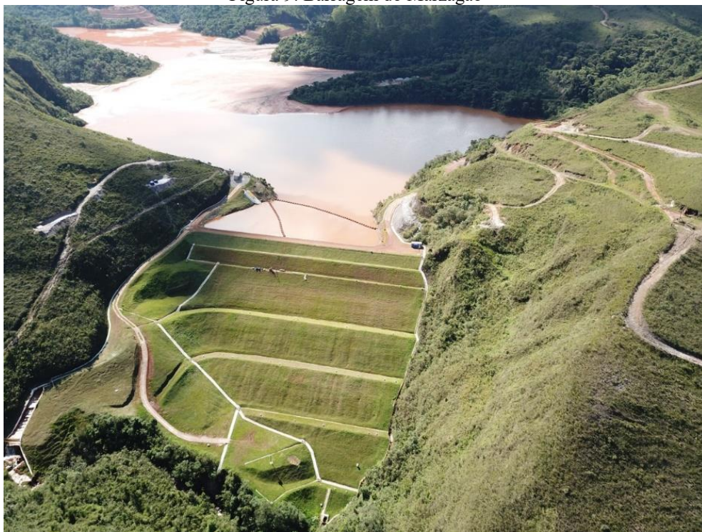
Figura 9: Barragem do Marzagão
