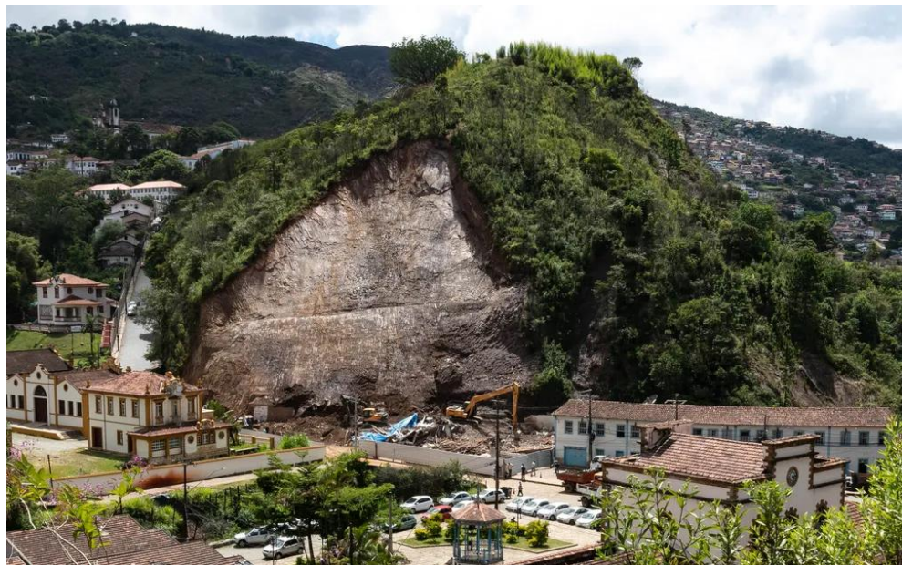
Figura 3 - Deslizamento em Ouro Preto
