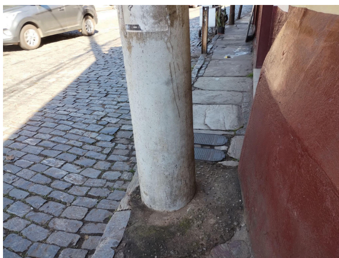
Figura 15: Situação de poste na Rua dos Inconfidentes (Fonte: acervo da autora)
