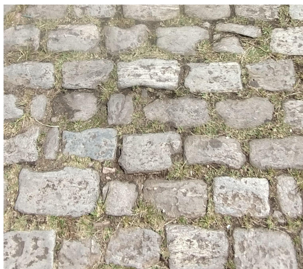
Figura 17: Paralelepípedos de pedra utilizados na pavimentação da Rua dos Inconfidentes. (Fonte: acervo pessoal da autora)
