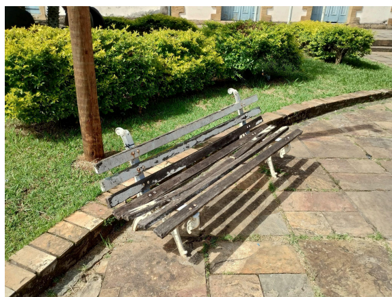
Figura 28: Bancos de madeira deteriorados na Praça da Estação. (Fonte: acervo pessoal da autora)
