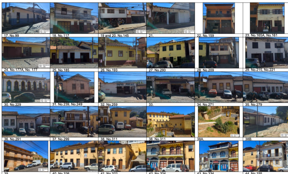
Figura 11: Quadro de fotos das fachadas das edificações da Rua dos Inconfidentes, parte 2 (Autoria: Matei Popescu, 2024. Fonte: acervo Plus Ultra; alterações feitas pela autora)
