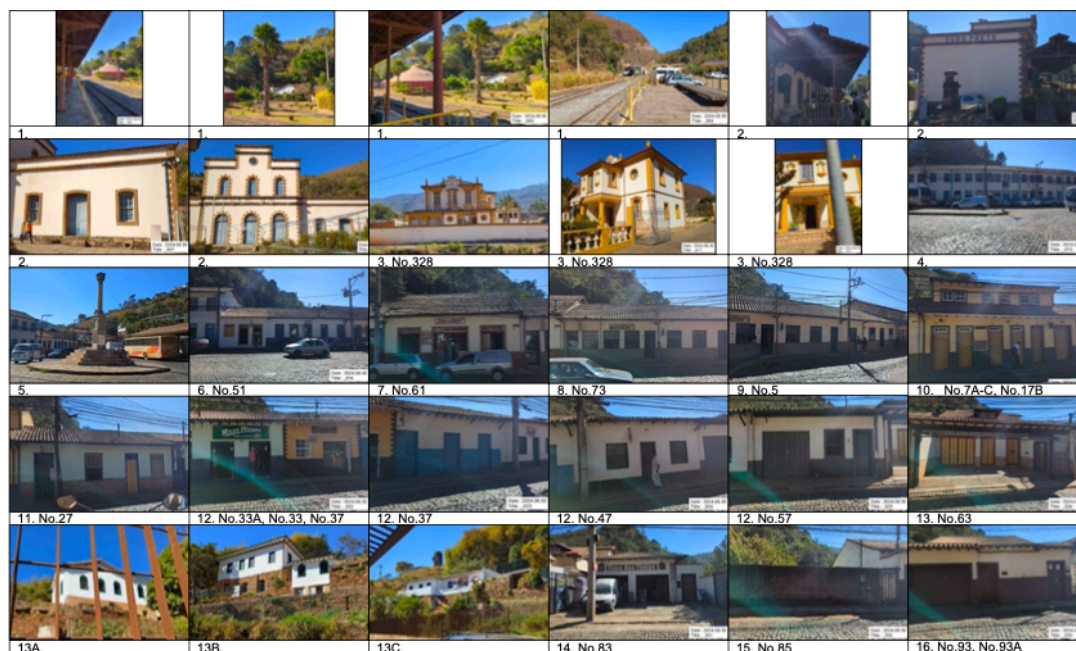
Figura 10: Quadro de fotos das fachadas das edificações da Rua dos Inconfidentes, parte 1 (Autoria: Matei Popescu, 2024. Fonte: acervo Plus Ultra; alterações feitas pela autora)
