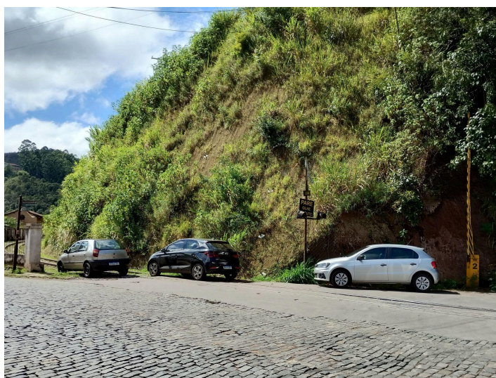
Figura 54: Estacionamento improvisado na ferrovia. (Fonte: acervo pessoal da autora)
