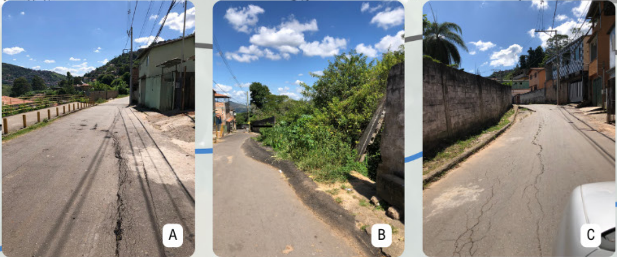
Figura 30: Ruas do bairro com constante trinca e desnível devido a movimentação do solo
