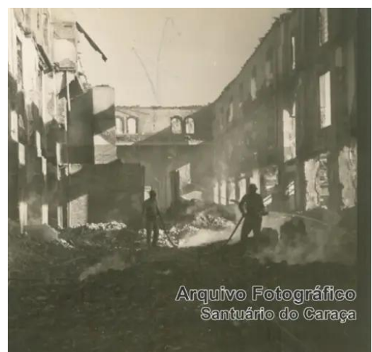
Figura 7: Registro após o incêndio
