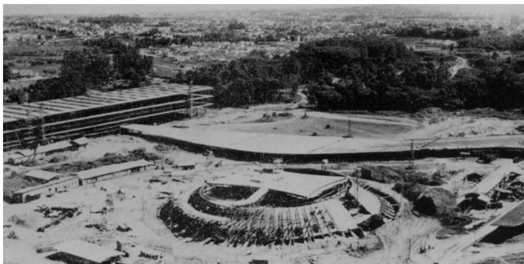
Figura 2 2 - Vista aérea do parque em execução. Nota-se a utilização do vazio ainda não vegetado com um parque de diversões.
