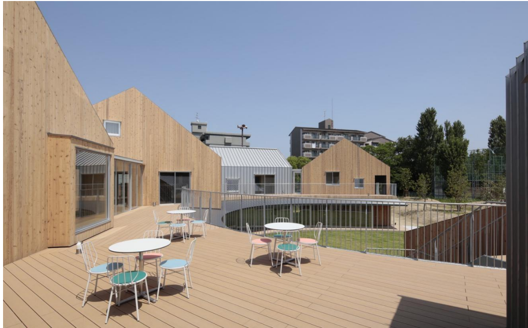
Figura 14 - Deck do Hospital TSURUMI.
