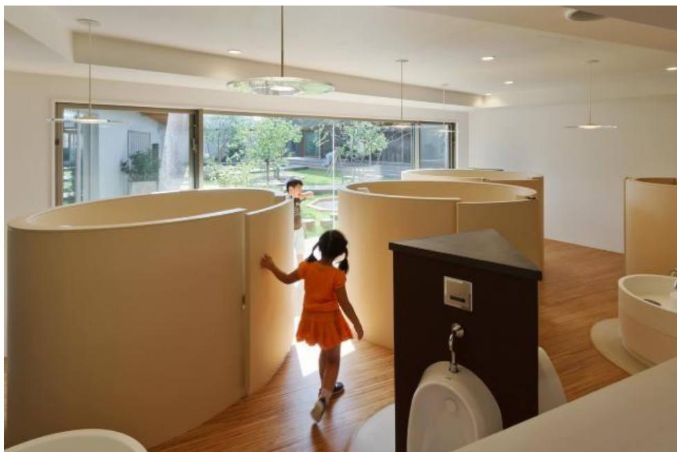
Figura 4 - Banheiro da Creche D.S
