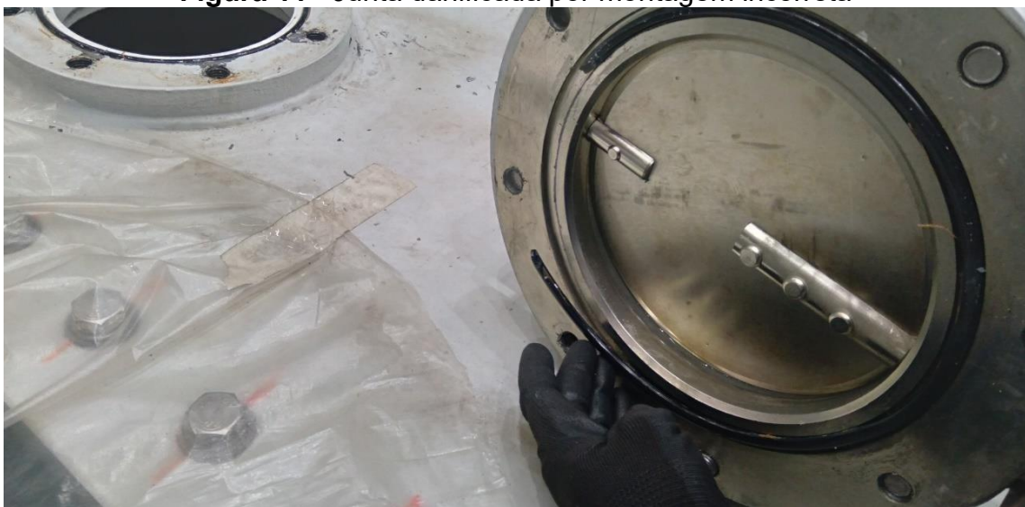
Figura 11 - Junta danificada por montagem incorreta
