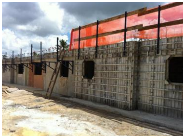
Figura 2 - Sistema construtivo de paredes de concreto moldadas in loco sendo executadas no canteiro de obras
