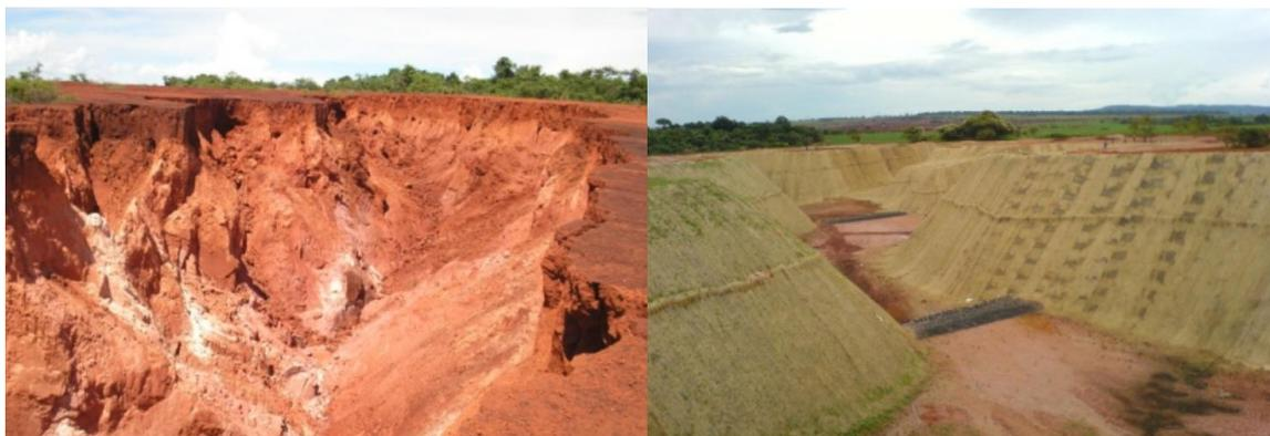
Figura 22: a) Área erodida antes do projeto de recuperação. b) Área após a execução do projeto elaborado pelo empresa DeFlor, Bioengenharia (Boletim Técnico DeFlor Bioengenharia)
