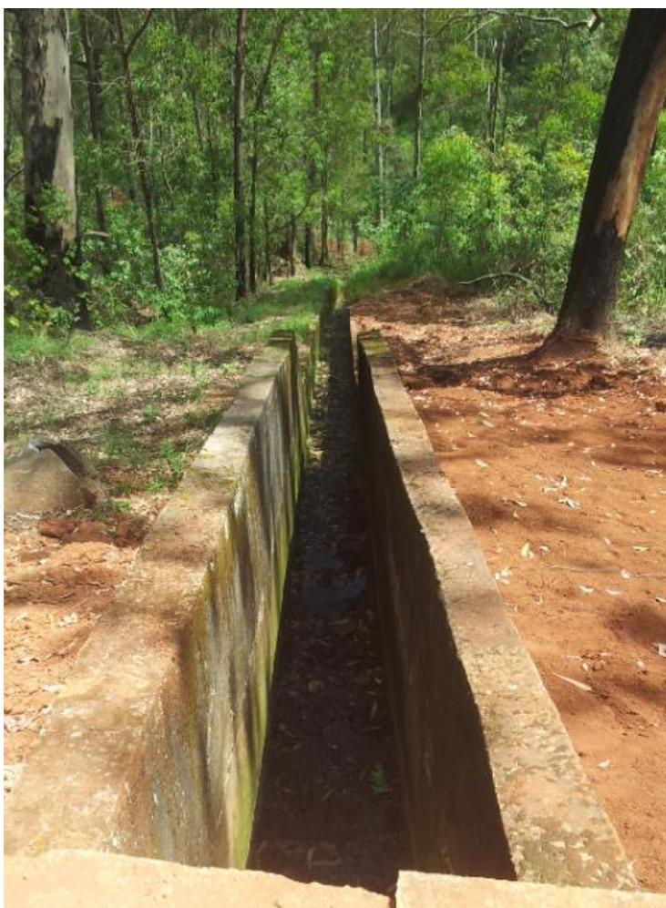
Figura 17: Canaleta longitudinal de concreto existente a oeste da cavidade da voçoroca.
