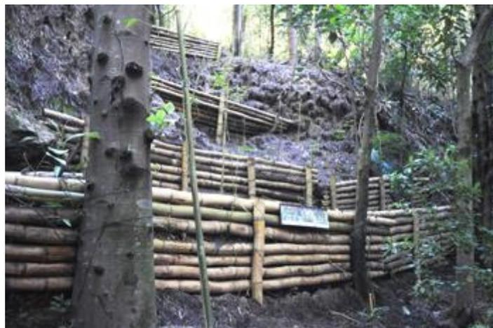
Figura 20: Paliçadas para a contenção de processos erosivos (Jornal da PUC. Disponível em: <<http://jornaldapuc.vrc.puc-rio.br/cgi/cgilua.exe/sys/start.htm?infoid=2755&sid=24>> . Acessado em: 13 fev. 2016.
