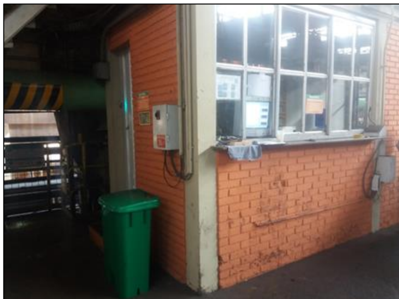
Figura 13 – Janelas reparadas na sala próxima a linha de laminação
