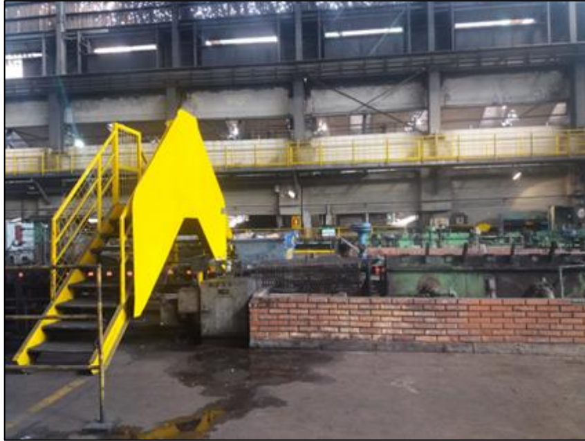
Figura 12 – Pintura de corrimãos e grades de proteção
