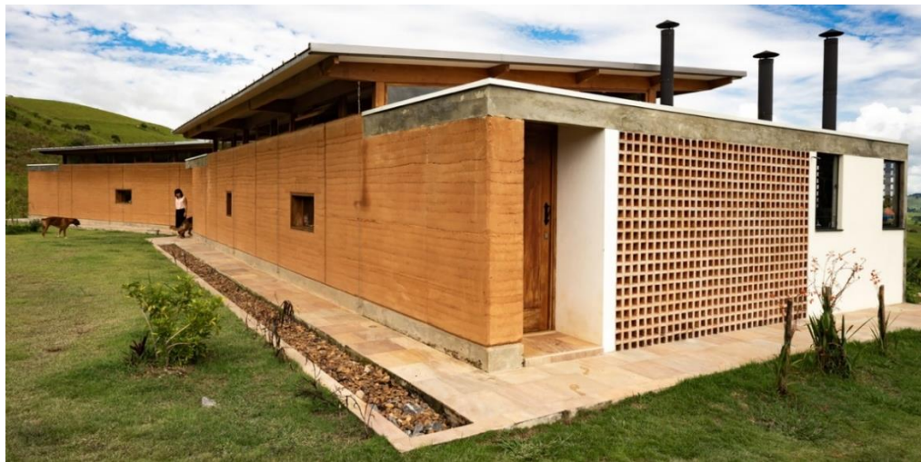
Figura 6: Fachada da casa feita de taipa de pilão.
