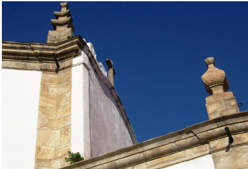
IMAGEM 9 – Estrutura com pilastra de pedra e coruchéu
