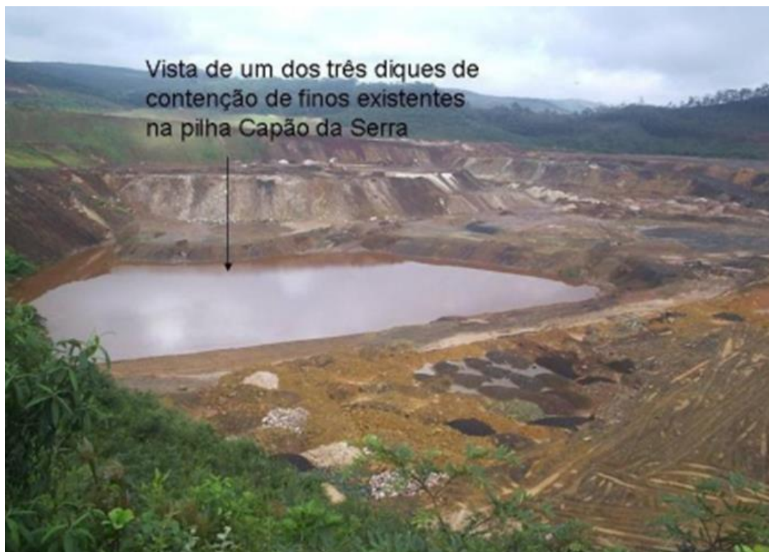
Figura 22 - - Vista de um dos diques de contenção de finos em cima da pilha (Fonte: Aragão, 2008)
