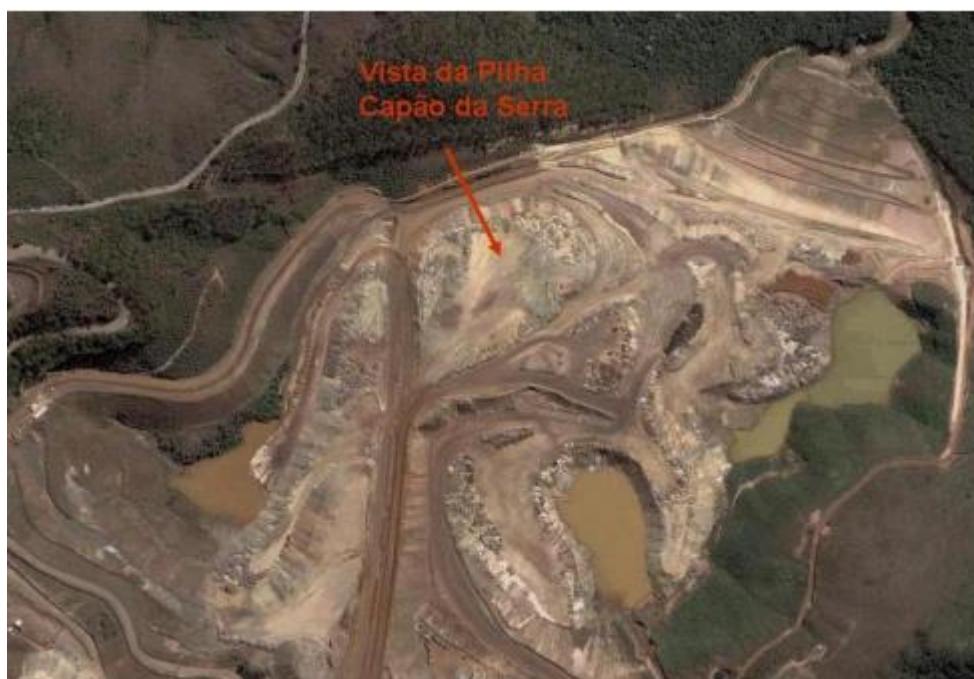
Figura 23 - Imagens de satélite da pilha Capão da Serra em construção (Fonte:Aragão, 2008).
