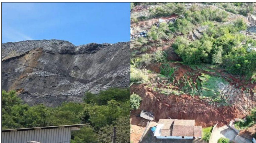
Figura 16 - Deslocamento de Pilha em mina de Turmalina. (Fonte: ANM, 2025)
