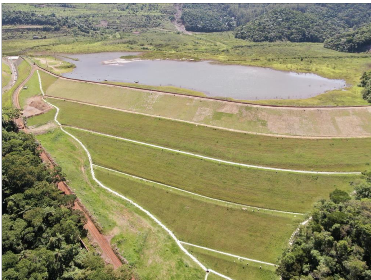
Figura 2 - Barragem de Rejeito (Fonte: IBRAM, 2024).
