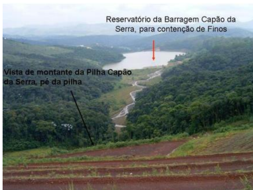
Figura 24 - - Vista do pé da Pilha (Fonte: Aragón, 2008).
