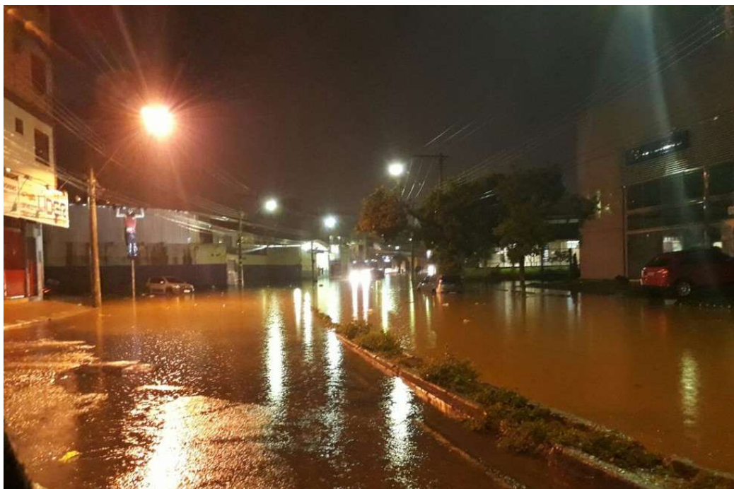
Figura 1 – Chuva forte causa alagamento em Ipatinga.
