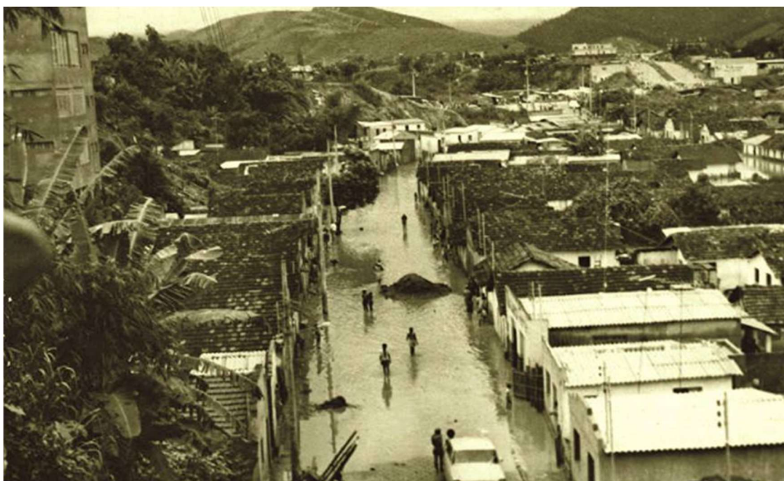
Figura 10 - Rua São José no bairro Bom Jardim em Ipatinga, após a enchente de 1979.
