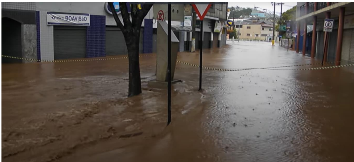
Figura 24 – Trecho da Rua Dr. Guilherme atingido pela inundação de 2012 no município de Itabirito (AGITOMAS, 2012).
