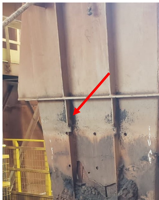
Figura 25: Desgaste na estrutura do chute Fonte: Pesquisa direta (2024)
