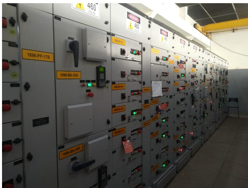
Figura 3 – CCM da planta de filtragem de rejeitos na qual foram realizados os testes. Autor (2023).
