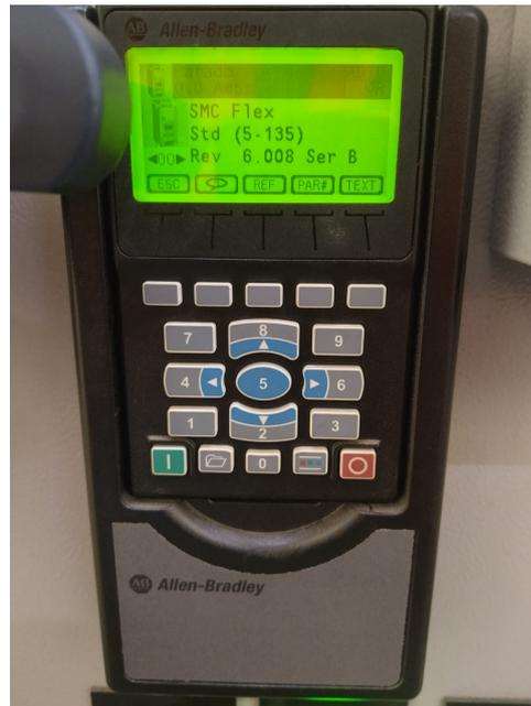
Figura 9 – Exemplo de Inversor de Frequência. Autor (2023).
