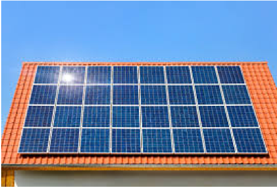
Figura 7 – Painéis fotovoltaicos instalados no telhado de uma residência.
